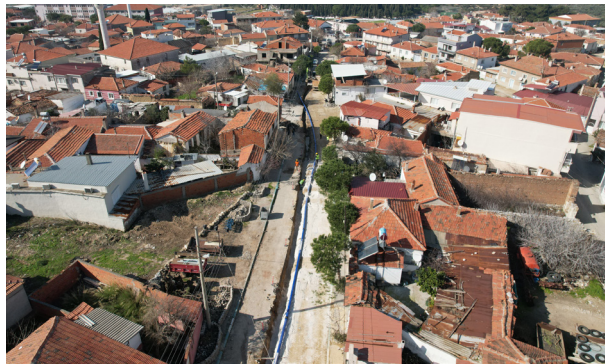
Bergama ilçesi Yukarıada ve Zeytindağ İçme Suyu Şebeke İnşaatı
