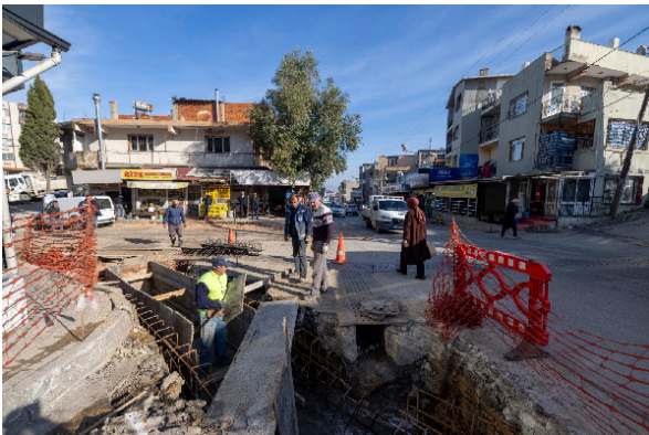
Karabağlar İlçesi Yağmur Suyu Arıza Giderme Çalışması
