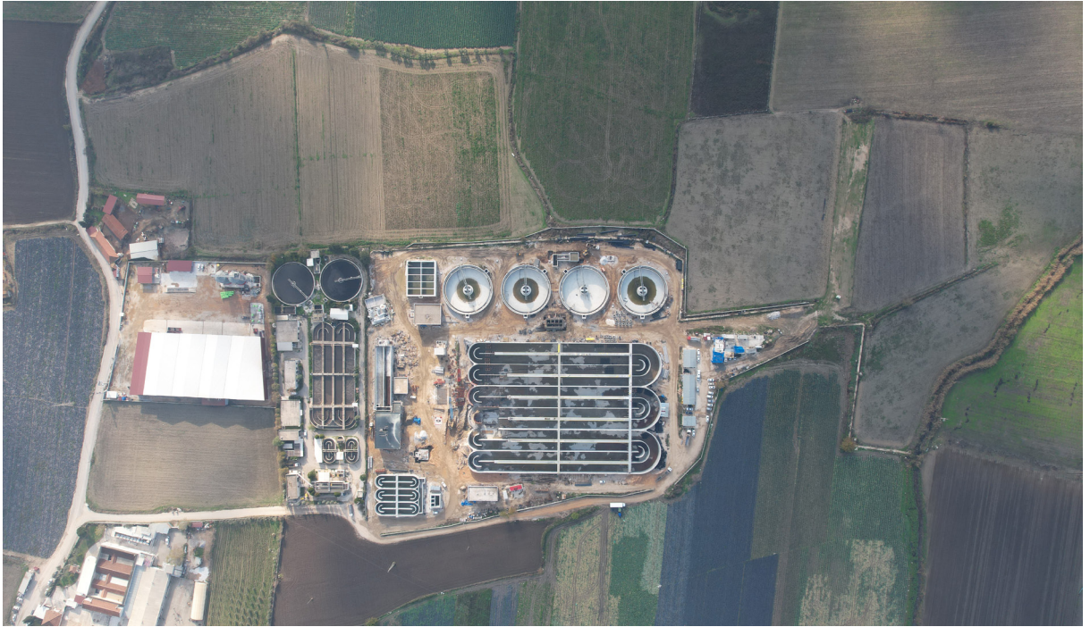
Torbalı Atık Su Arıtma Tesisi 2. Etap İnşaatı
