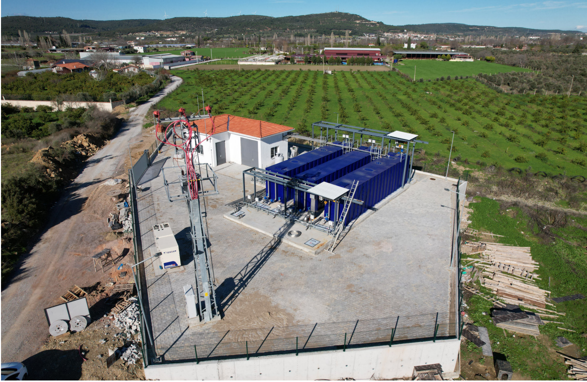
Seferihisar Düzce-Turgut Mahallesi Paket Atık Su Arıtma Tesisi İnşaatı
