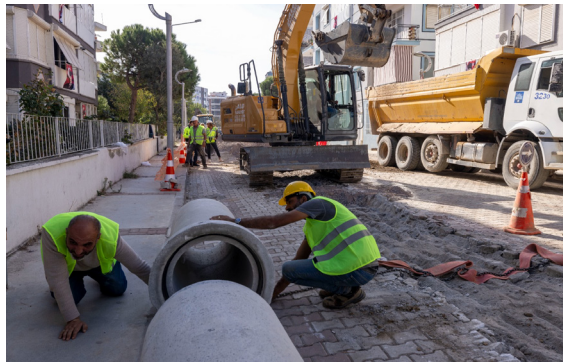
Menemen İlçesi Ulukent Terfi Merkezi ve İletim Hattı İnşaatı
