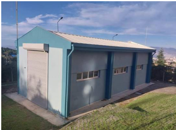
Uzundere TOKİ Hizmet Tesisi Bakım Onarım Çalışması
