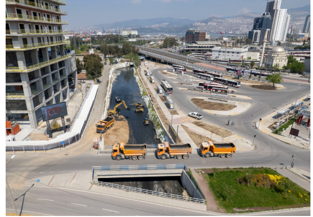
Meles Deresi Sümerbank Mevki, Meles-Arap Dereleri Birleşim Noktası Temizlik Çalışmaları
