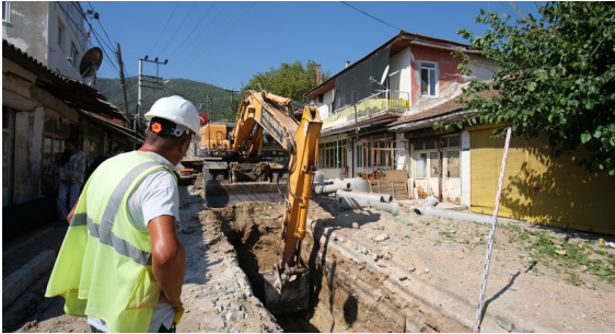
Menderes İlçesi Değirmendere Mahallesi Atık Su Şebeke İnşaatı
