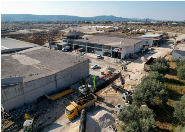
Bergama İlçesi İslamsaray Mahalle Alanları Yağmur Suyu İnşaatı İşi
