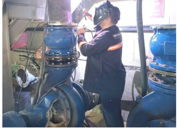
Halkapınar İçme Suyu Arıtma Tesisi Mekanik Bakım Çalışması
