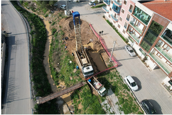
Kemalpaşa İçme Suyu Sondaj Kuyusu İnşaatı İşi
