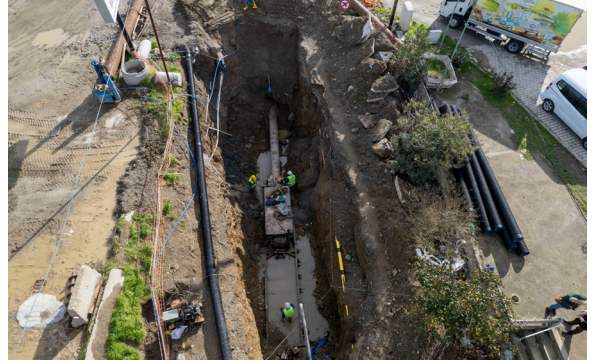
Seferihisar İlçesi Tepecik Mahallesi Cazibeli Atık Su İletim Hattı İnşaatı İşi
