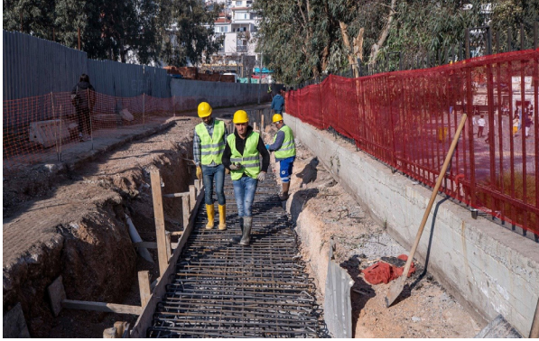
Çiğli İlçesi Şirintepe, Güzeltepe ve Yakakent Mahalleleri Muhtelif Sokaklarında Yağmur Suyu İnşaatı İşi
