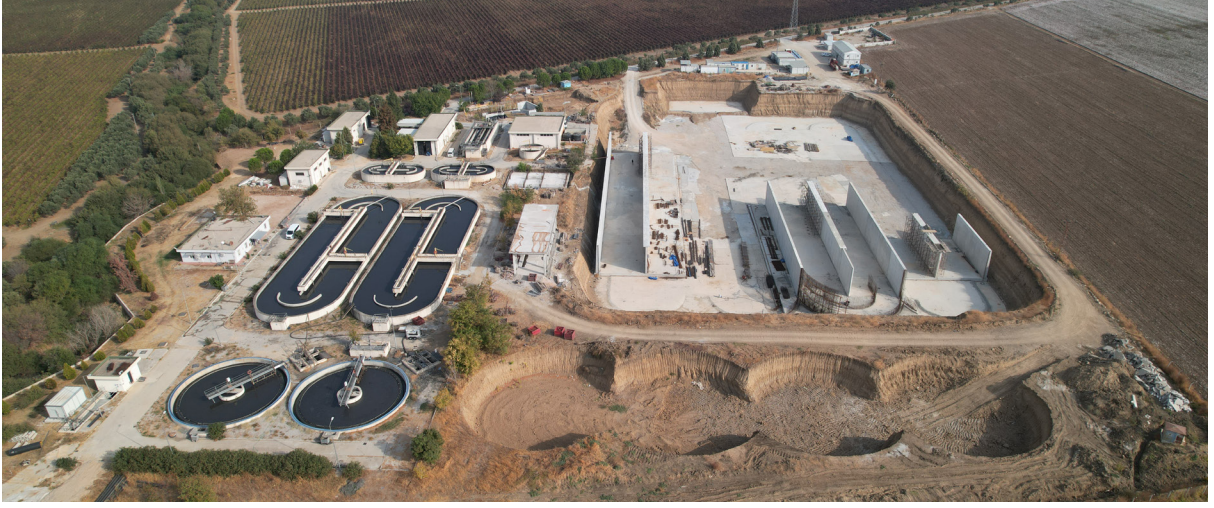
Torbalı Yazıbaşı-Ayrancılar Atık Su Arıtma Tesisi 2. Etap inşaatı
