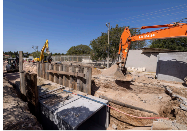
Buca İlçesi Kozağaç Muhtelif Mahalleleri Atık Su,
