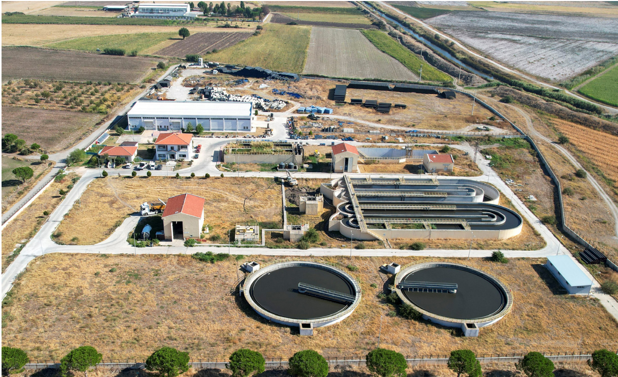
Bergama Atık Su Arıtma Tesisi
