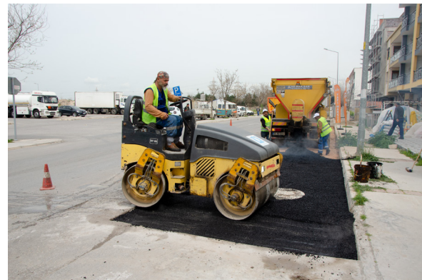
Menemen İlçesi Asfalt ve Kaplama Çalışmaları
