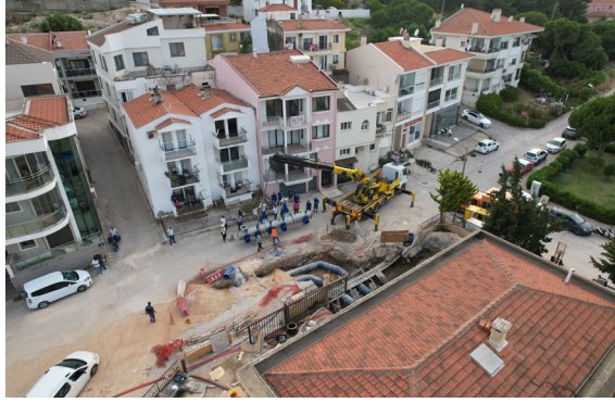
Çeşme İlçesi TM2 ve TM6 Atık Su Terfi Merkezlerinin Boru Bağlantılarının ve Bağlantılı Yapıların Onarımı ve İnşaatı
