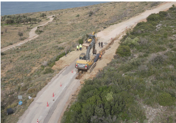
Karaburun İlçesi Bozköy Göleti İçme Suyu İletim Hattı İnşaatı
