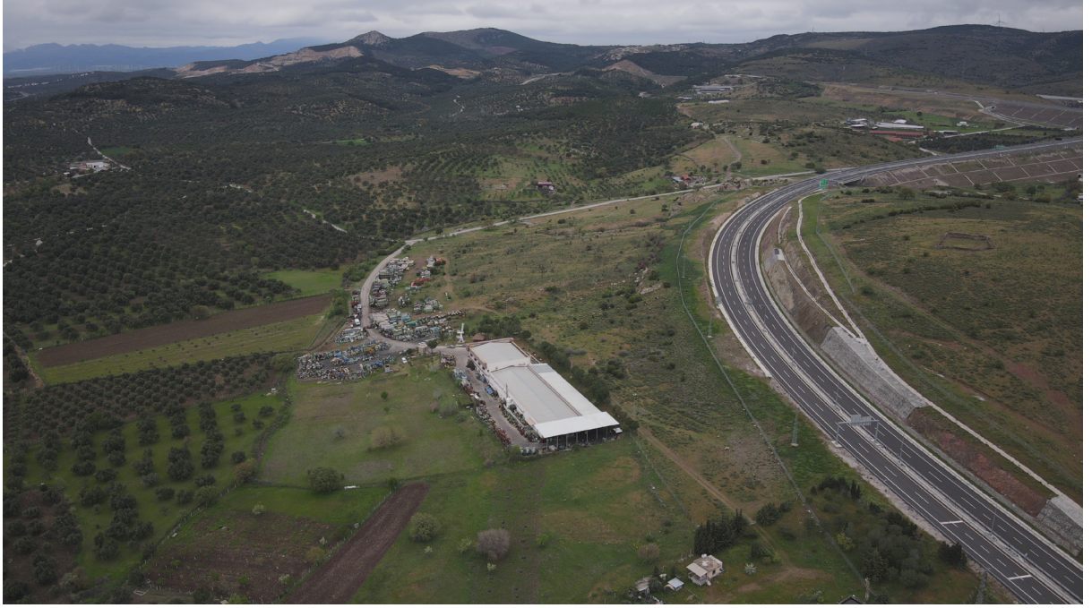
Aliağa Yenişakran Atık Su Arıtma Tesisi İnşaatı
