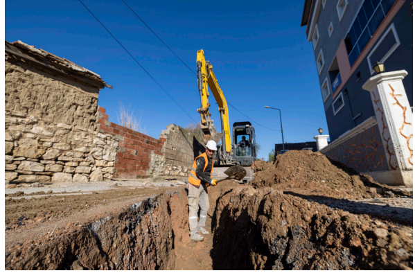
Menemen İlçesi Seyrek Merkez ve Çevre Mahalleleri İçme Suyu İnşaatı İş
