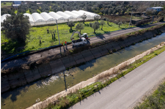
Menemen İlçesi Emiralem ve Türkelli Mahalleleri İçme Suyu Şebeke ve İletim Hattı ve Yeni Foça İletim Hattı İmalat Çalışması
