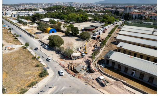
Buca İlçesi Kozagaç Deresi Atık Su Şebeke Hattı İnşaatı
