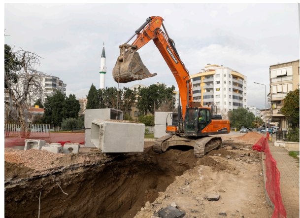
Bornova İlçesi Kazımdirik, Mansuroğlu Mahalleleri Yağmur Suyu Kanalı İnşaatı
