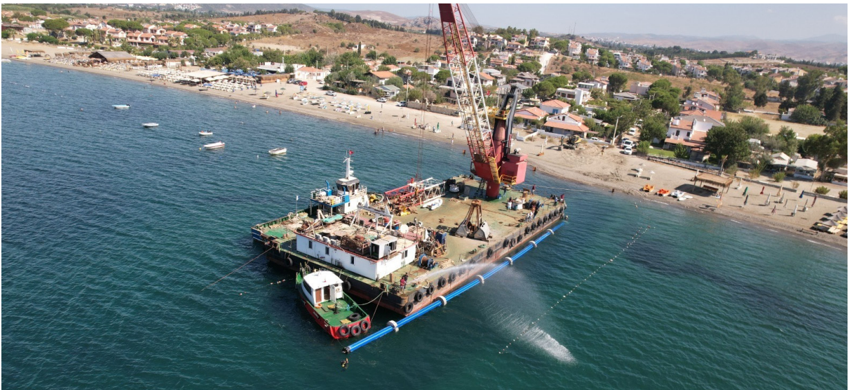
Seferihisar Akarca Deniz Deşarjı Hattı İnşaatı
