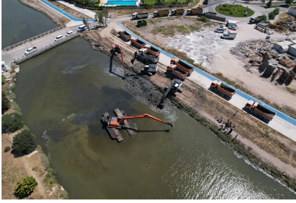
Mavişehir Deresi Temizlik Çalışmaları
