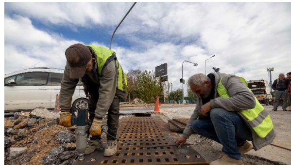
Tekli Yağmur Suyu Izgara Yapımı Çalışması
