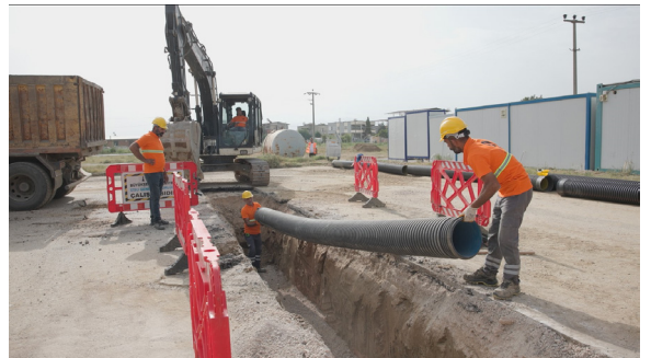
Torbalı İlçesi Subaşı Mahallesi Atık Su Şebeke İnşaatı
