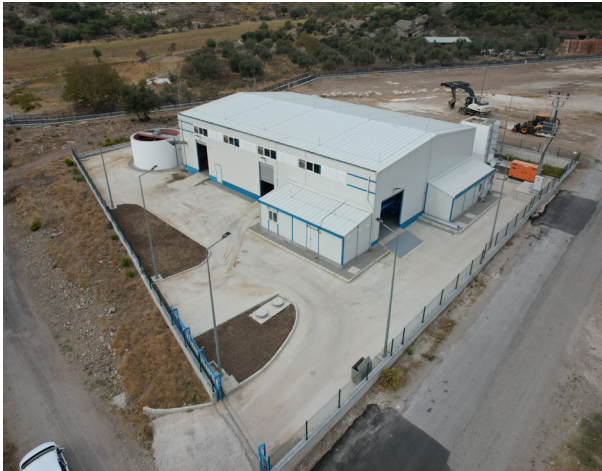
Dikili Çandarlı Göleti İçme Suyu Arıtma Tesisi
