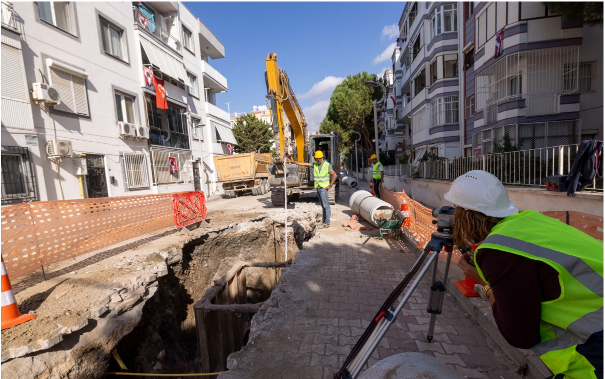
Menemen İlçesi Kanalizasyon Altyapı Çalışmaları
