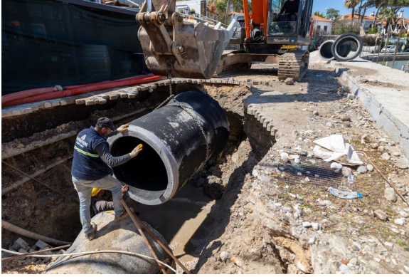
Büyük Kanal Yenileme Çalışmaları
