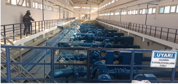
Pompa İstasyonu Tadilat Çalışması
