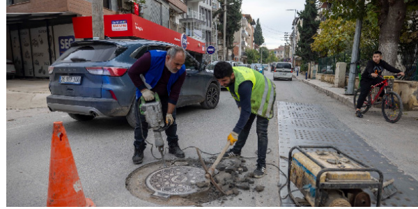
Baca Kapak ve Izgaraların Yol Seviyesine Getirilmesi Çalışması
