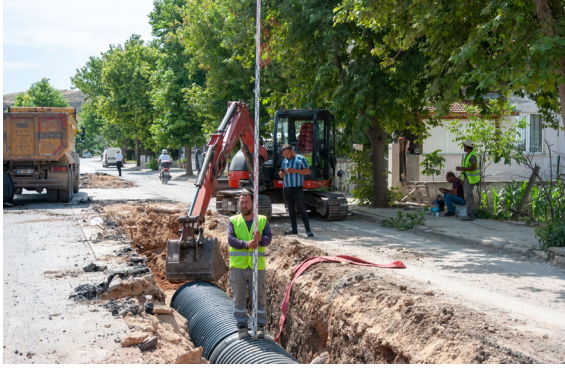
Urla İlçesi Muhtelif Mahalleler Atık Su İletim Hattı İnşaatı
