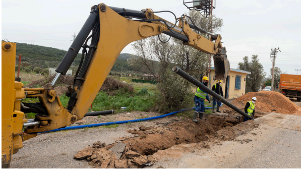
Karaburun İlçesi Eğlenhoca, Esendere, Saip ve Küçükbahçe Mahalleleri İçme Suyu İnşaatı İşi
