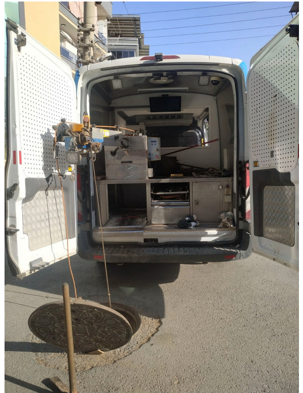
Kanalizasyon Hatlarının Temizliği Çalışmaları
