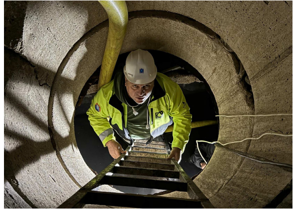
Galeri Mecra Hattının Bakım, Onarım ve Temizliği
