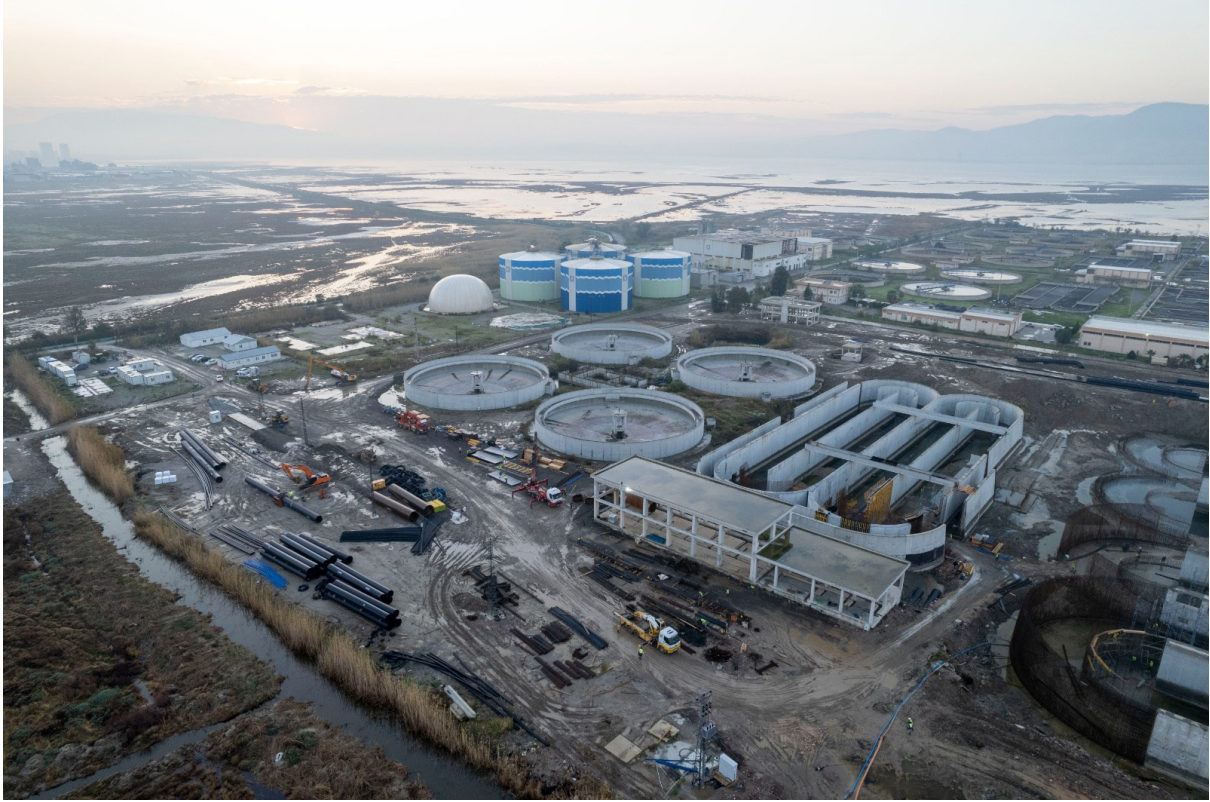
Çiğli Atık Su Arıtma Tesis 4. Faz İkmal İnşaatı
