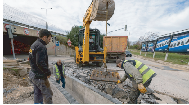
Sıralı Yağmur Suyu Izgarası Bakım, Onarım ve Tamiratının Yapılması
