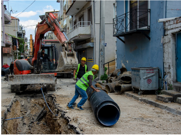
Konak İlçesi Gültepe Bölgesi Muhtelif Cadde ve Sokaklarında Yağmur Suyu Kanalı İnşaatı
