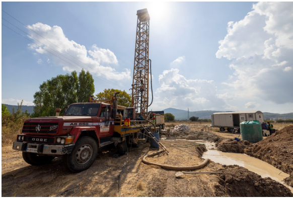
Yarımada İçme Suyu Sondaj Kuyusu İnşaatı İşi
