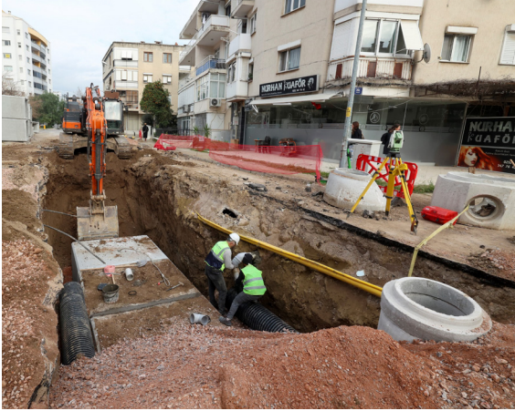
Mansuroğlu Mahallesi Atık Su Şebeke İnşaatı
