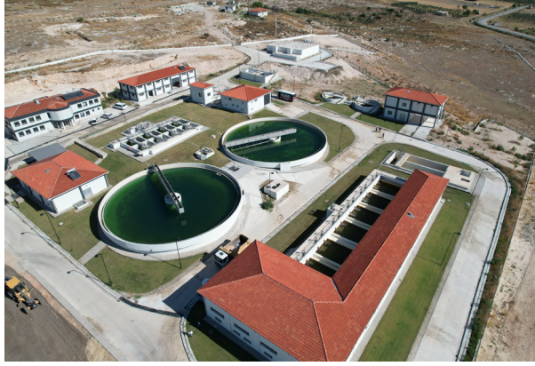
Foça-Yenifoça, Musabey Kuyuları İçme Suyu Arıtma Tesisi Açılışı
