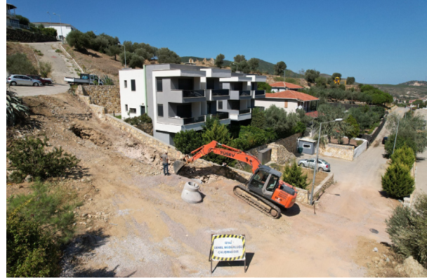
Foça İlçesi Mustafa Kemal Atatürk Mahallesi Atık Su Şebeke Hattı İnşaatı
