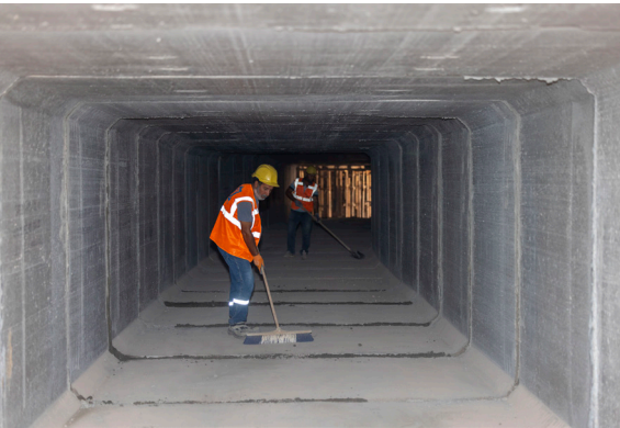
Buca İlçesi Kozagaç Deresi Atık Su Şebeke Hattı İnşaatı
