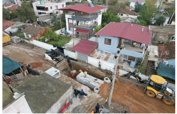
Torbalı Teknik Şube Müdürlüğü Sorumluluk Alanında Kanalizasyon Yağmur Suyu Hattı ve Bina Kolu Yapımı İşi
