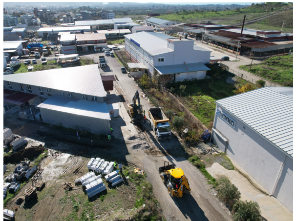
Seferihisar İlçesi İçme Suyu İnşaatı İş
