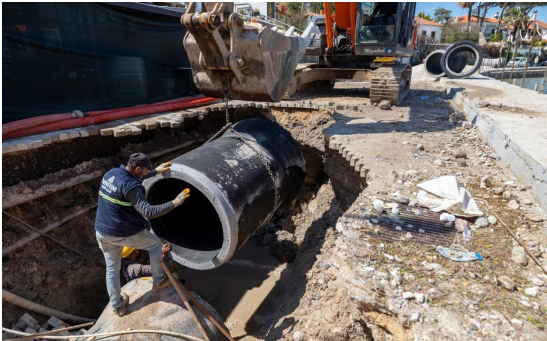
Kısa Metrajlı Kanalizasyon Hattı İmalatı
