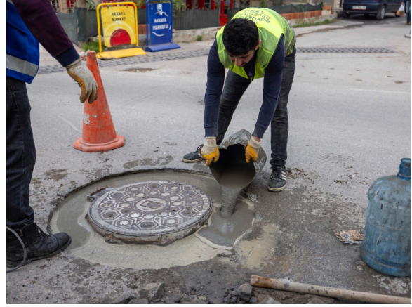
Kanalizasyon Baca Kapak Seviyelerinin Yol Seviyesine Getirilmesi
