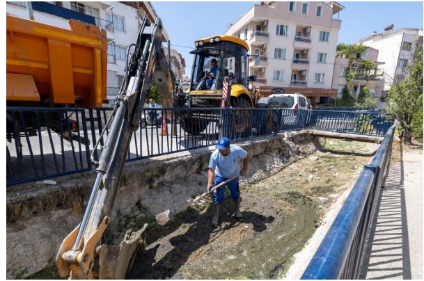
Dikili İlçesi Deresi Temizlik Çalışmaları
