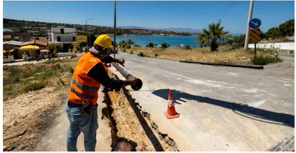
Çeşme ilçesi ve Bağlı Mahalleleri 3. Etap İçme Suyu İnşaatı İşi
