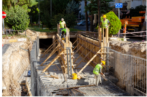
Balçova Çetin Emeç Mahallesi Dere Islahı işi
