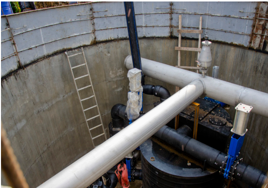
Yağmur Suyu Pompa İstasyonu Bakım ve Onarım Faaliyetleri
