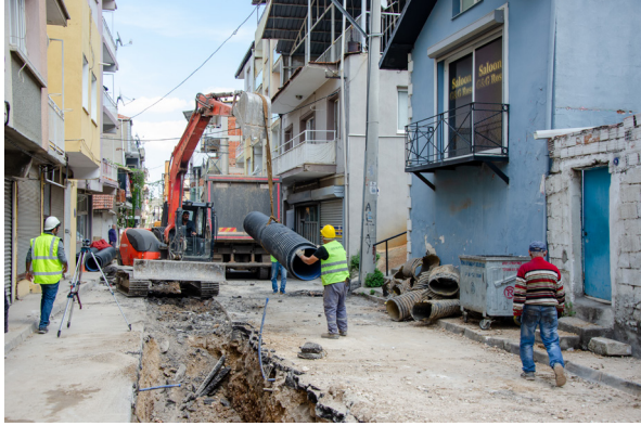
Konak İlçesi Yağmur Suyu Ayırıştırma Hattı İnşaatı İşi
