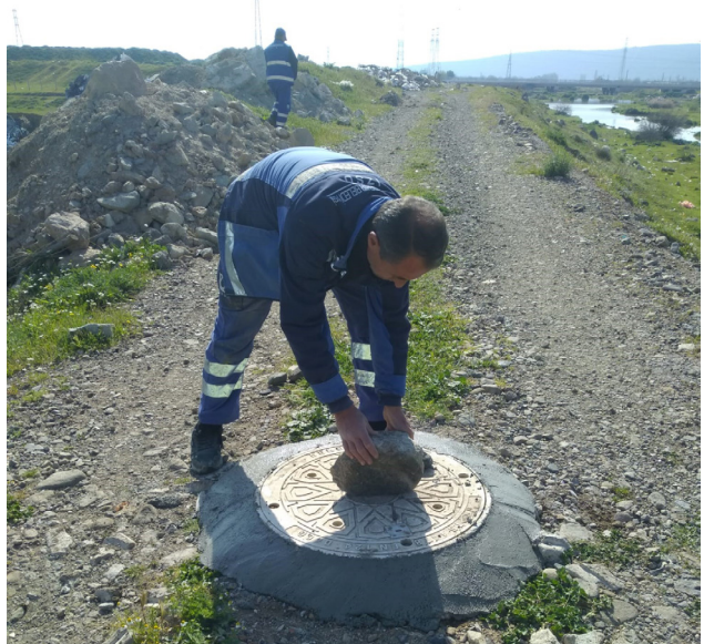
Kanalizasyon Baca Kapak ve Yağmur Suyu İzgaralarının Yol Seviyesine Getirilmesi
