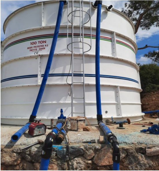
Kemalpaşa Sinancılar Köyü İçme Suyu Deposu Yenileme İş
