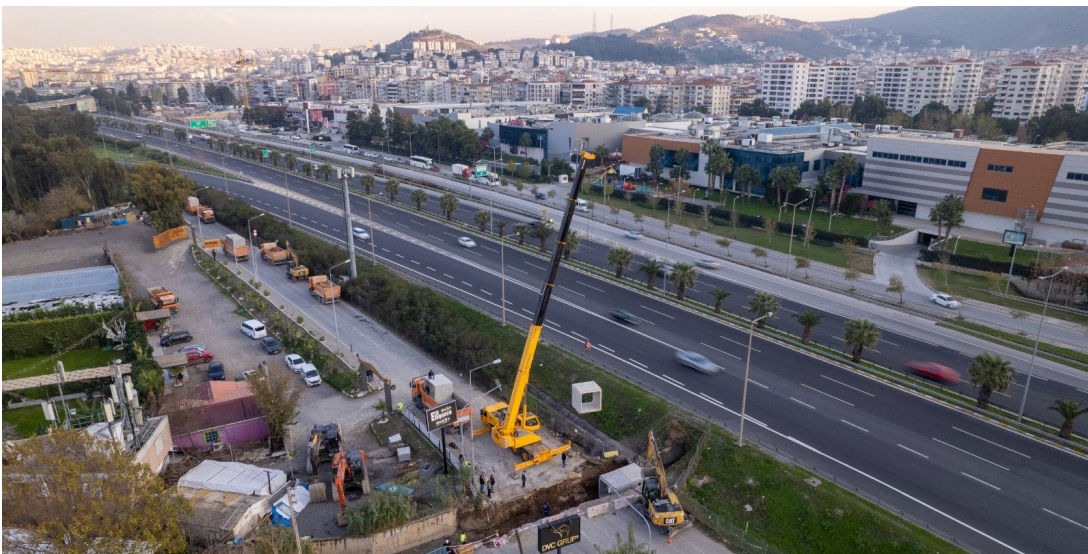
Balçova Mollakuyu Deresi Geçiş Menfez İmalatı
