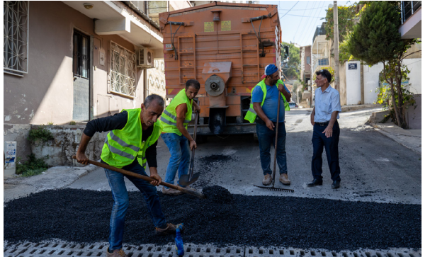
Asfalt Kaplama Faaliyetleri
