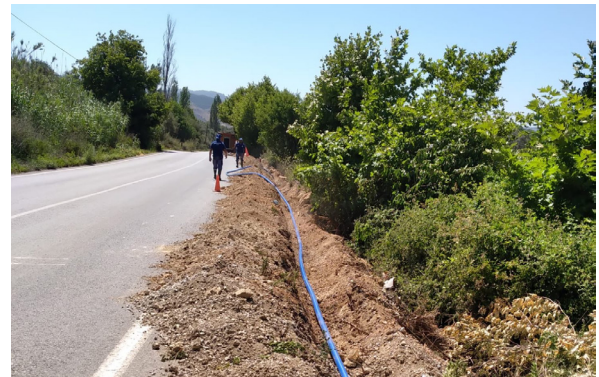
Urla İlçesi İçmeler ile Çeşme Arası 2.Etap İçme Suyu İletim Hattı ile Karaburun İlçesi Bozköy Göleti İçme Suyu İletim Hattı İnşaatı
