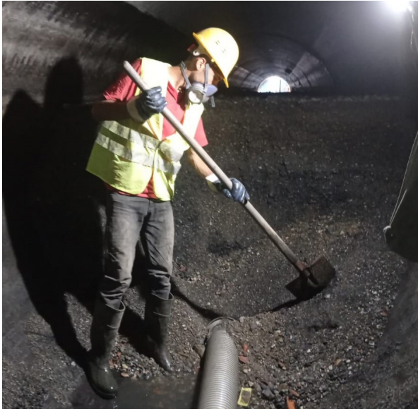
Galeri Mecra Hattının Bakım, Onarım ve Temizliği Faaliyetleri
