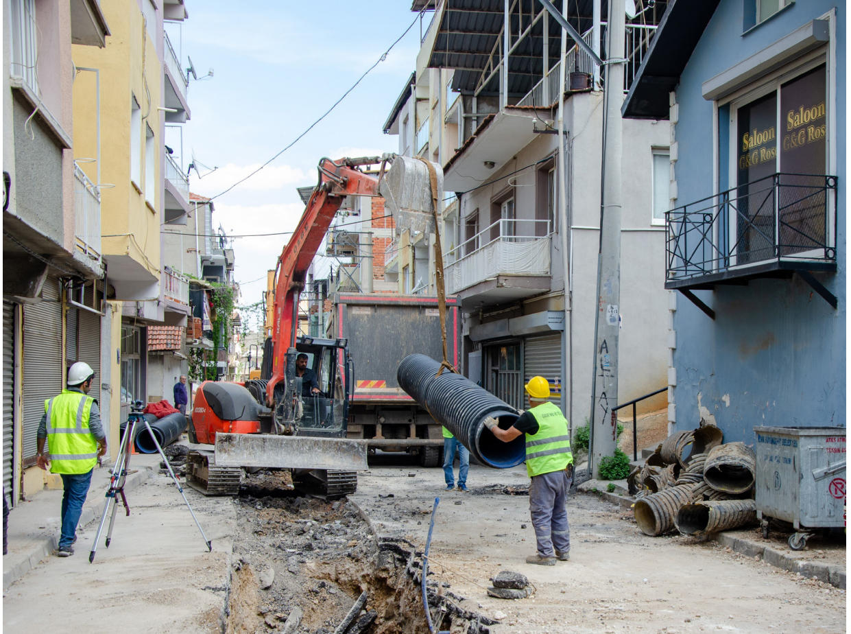
Konak İlçesi Gültepe Bölgesi Muhtelif Cadde ve Sokaklarında Atık Su Kanalı İnşaatı
