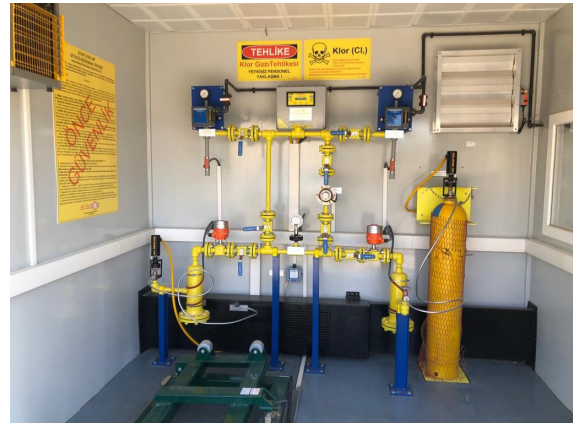
Acil Müdahale Sistemli Paket Klorlama Sistemi
