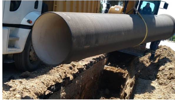
Karşıyaka Başpehlivan Kara Ali Cd. Üzeri Ø1000 Df Boru Döşemesi İşİ
