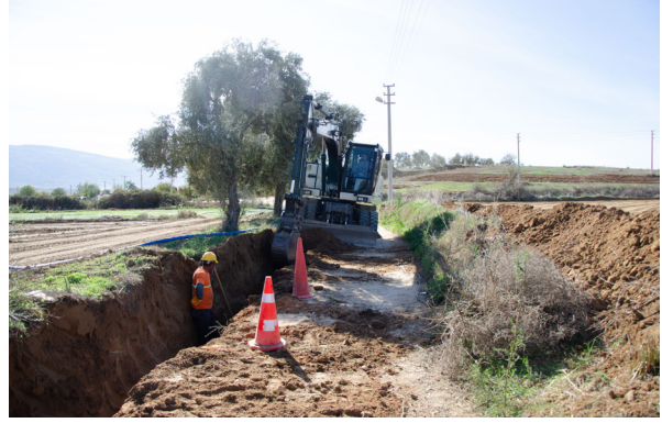
Tire İlçesi Derebaşı (Bayraktepe) Mahallesi İçme Suyu İnşaatı
