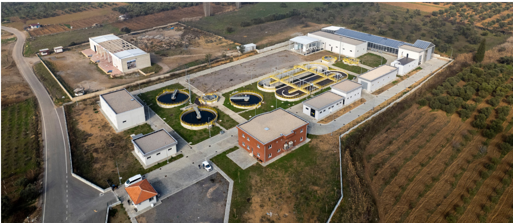
Kemalpaşa Ulucak Atık Su Arıtma Tesisi
