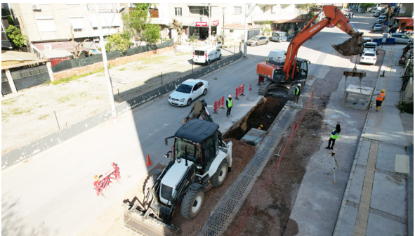
Buca İlçesi Yağmur Suyu Ayırıştırma Hattı İnşaatı İşi
