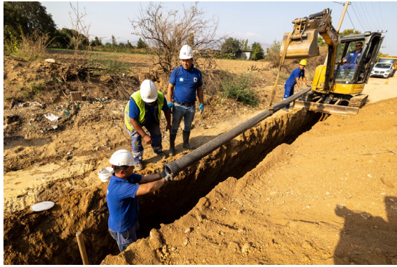
Ödemiş Çaylı İçme Suyu Hattı Yapımı İşİ
