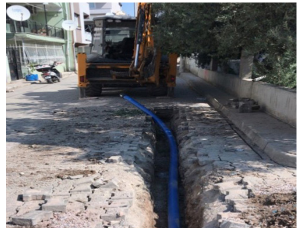
Gaziemir İlçesi Fatih Mahallesi 1099 sokak ve Çamlık Caddesi Su Şebeke Yenileme İşİ
