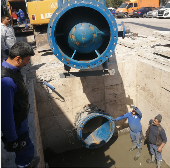
Bornova Ayakkabıcılar Sitesi Ø1000 İğne Vana Montajı Tamiri
