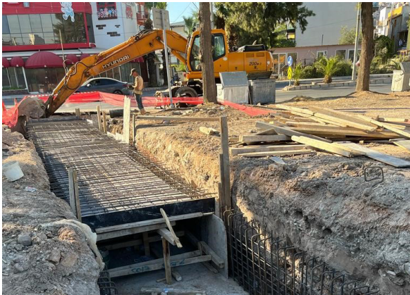
Sıralı Yağmur Suyu Izgarası Yapımı
