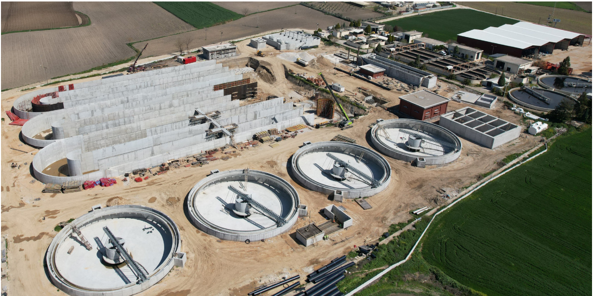
Torbalı-Ayrancılar Atık Su Arıtma Tesisi
