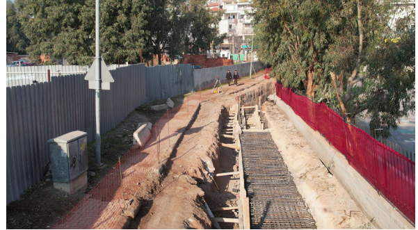
Çiğli İlçesi Yağmur Suyu Ayrıştırma Hattı İnşaatı İşi
