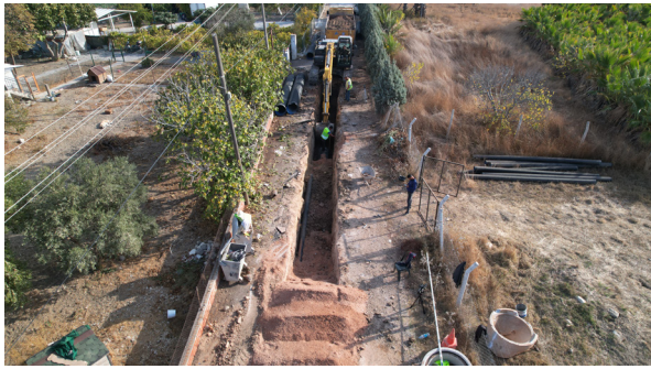
Urla İlçesi Yağmur Suyu Ayırıştırma Hattı İnşaatı İşi
