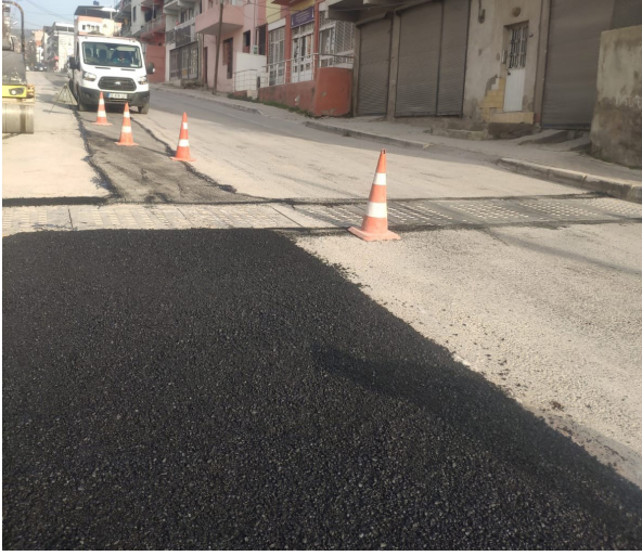
Çiğli İlçesi Şirintepe, Güzeltepe ve Yakakent Mahalleleri Muhtelif Sokaklarında Asfalt Kaplama İş'i. Etap İnşaatı
