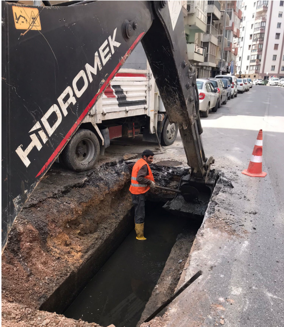
Galeri Mecra Hattının Bakım, Onarım ve Temizliği Faaliyetleri
