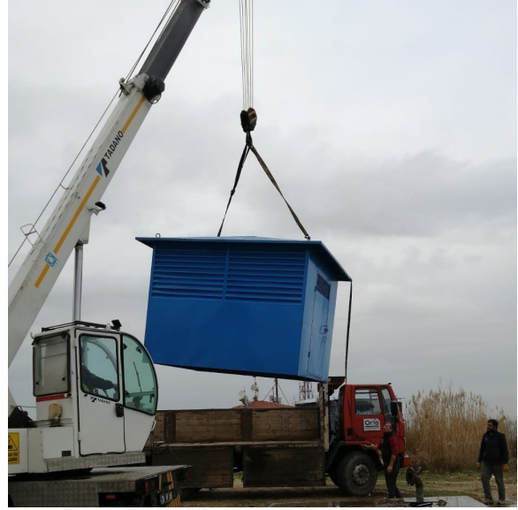
Menemen Alaniçi Mahallesi Sondaj Kuyusu İnşaatı
