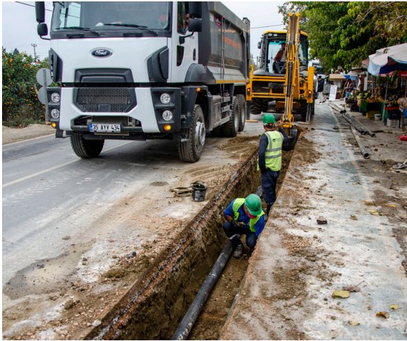
Seferihisar İlçesi İçme Suyu Şebeke İnşaatı
