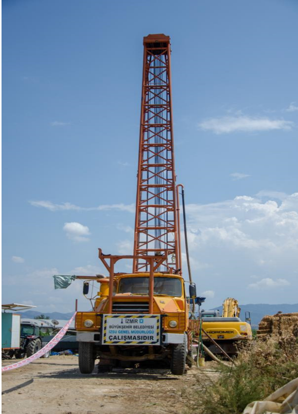
Torbalı İlçesinde Yapılan Sondaj Kuyusu Çalışması
