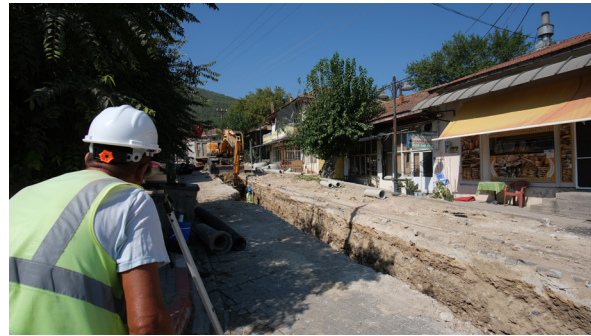
Menderes İlçesi Yağmur Suyu Ayırıştırma Hattı İnşaatı İşi
