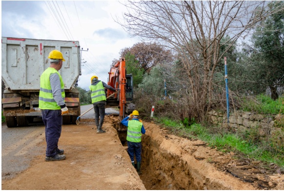
Kiraz İlçesi 1. Etap İçme Suyu İnşaatı
