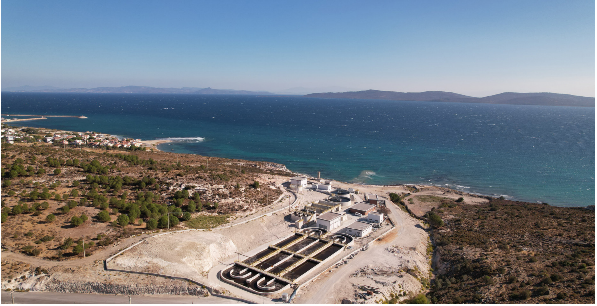
Karaburun Mordoğan Atık Su Arıtma Tesisi
