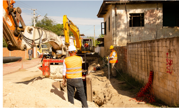
Bayındır İlçesi Yağmur Suyu Ayırıştırma Hattı İnşaatı İşi
