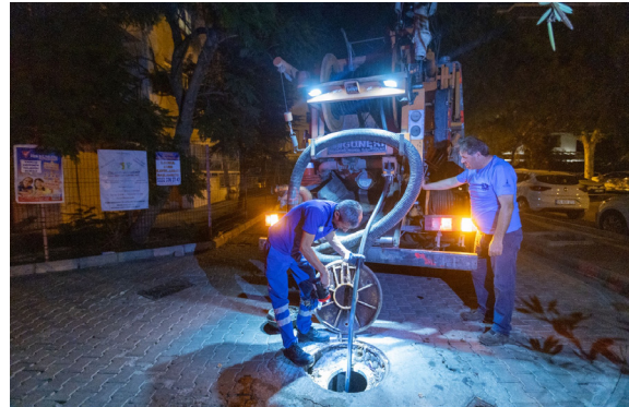
Kanalizasyon Hatlarının Temizliğinin Yapılması İşi
