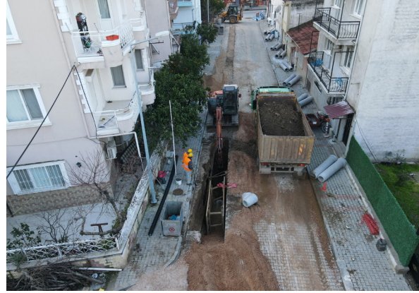
Kemalpaşa İlçesi Bağyurdu, Yiğitler, Ören, Armutlu, Yukarıkızılca, Aşağıkızılca, Örnekköy ve Çiniliköy Yerleşimleri Altyapı İnşaatı ve Elektrik İletim Tesisleri Yapım İş'i İnşaatı
