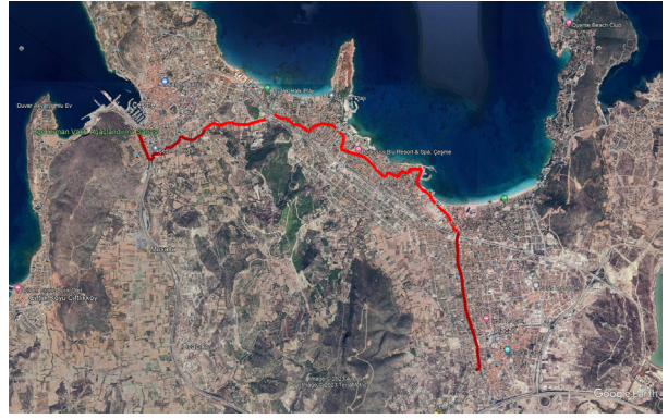
Çeşme İlçesi Tm2-Tm6 ve Tm6-Tm18 Arası Basınçlı ve Cazibeli Hatların İnşaatı
