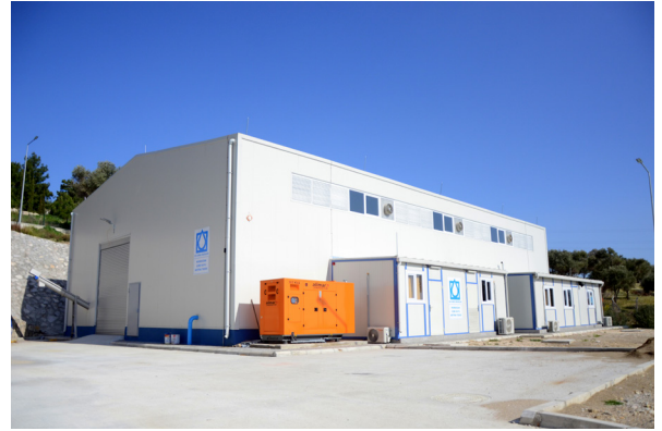
Karaburun Mordoğan İçme Suyu Arıtma Tesis
