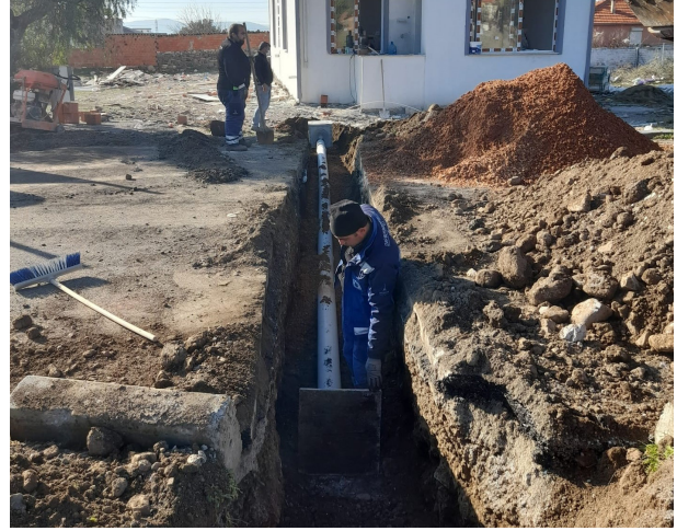
Mevcut Bina Kolu Bağlantıları Yapımı
