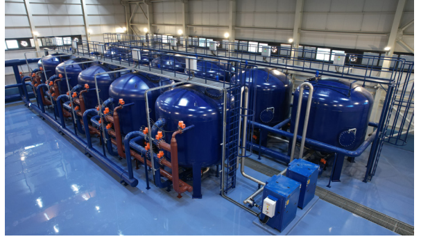
Halkapınar Kuyuları Arsenik Arıtma Tesis Kapasite Arttırımı İnşaatı
