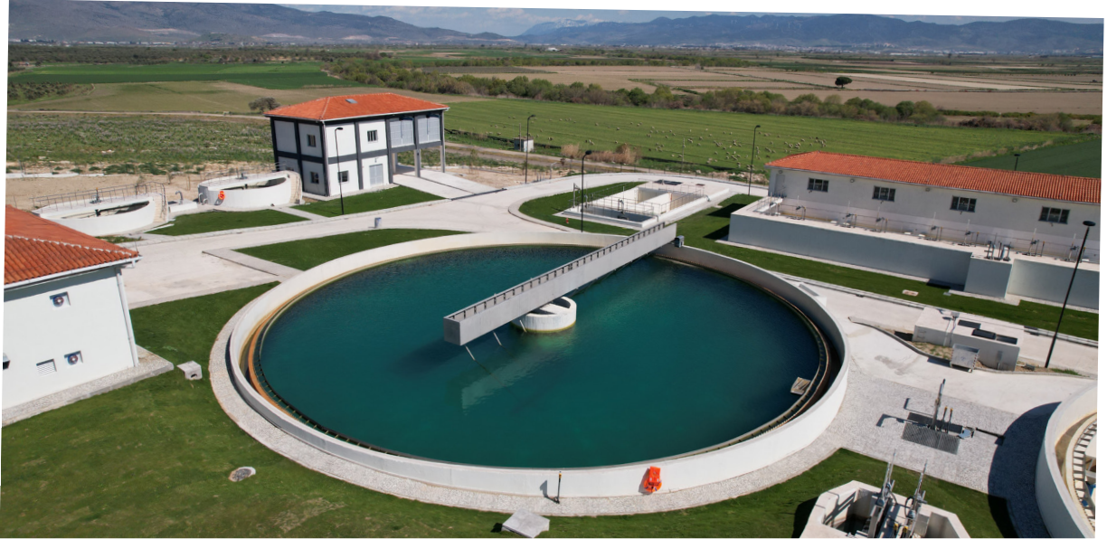
Foça, Yenifoça, Musabey Kuyuları İçme Suyu Arıtma Tesisi Yapım İnşaatı
