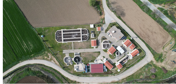
Bayındır Hasköy Atık Su Arıtma Tesisi
