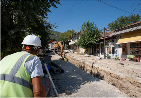
Menderes İlçesi Gümüldür Atatürk, Fevzi Çakmak ve Özdere Çukuraltı Mahallesi Atık Su Şebekesi İnşaatı
