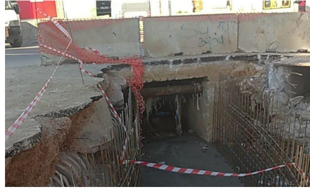
Karabağlar Kibar, Barış, Günlaltay, Selvili ve Ali Fuat Cebesoy Mahalleleri Muhtelif Cadde ve Sokaklarında Atık Su İnşaatı
