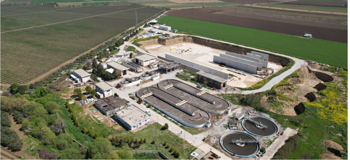
Torbalı Atık Su Arıtma Tesisi
