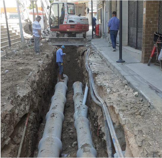
1.Bölge Kanalizasyon Hatlarının Yenilenmesi
