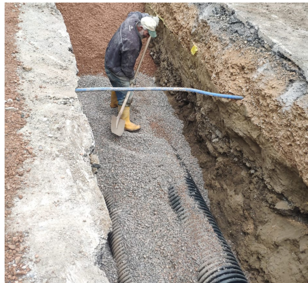
Çiğli İlçesi Şirintepe, Güzeltepe ve Yakakent Mahalleleri Muhtelif Sokaklarında Atık Su Şebekesi İnşaatı İşİ 1 Etap İnşaatı
