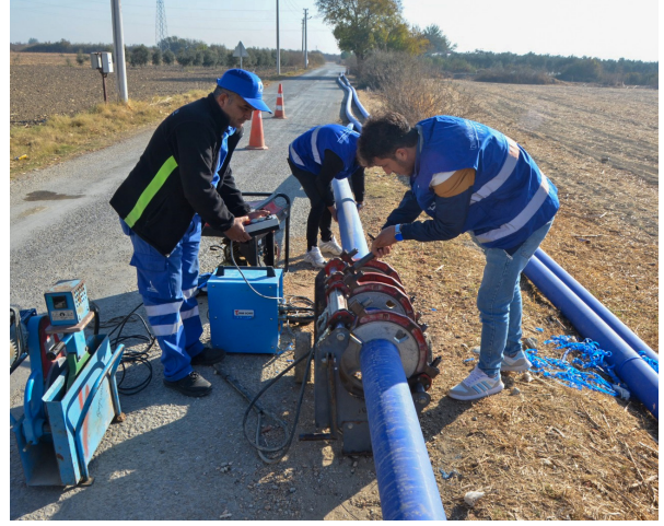
Torbalı İlçesi İçme Suyu Şebekesi İkmal İnşaatı
