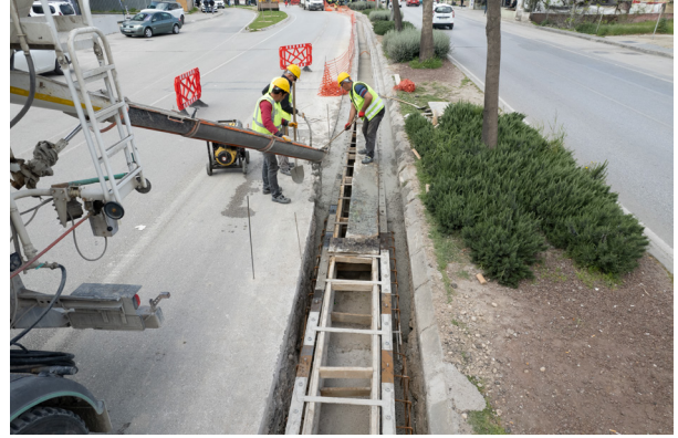
Bayraklı İlçesi Yağmur Suyu Ayrıştırma Hattı İnşaatı İşi
