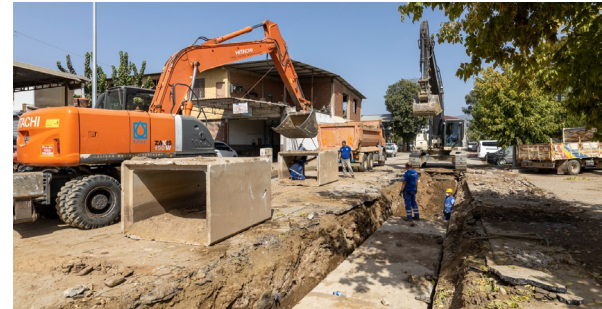
Ödemiş Kısa Metrajlı Yağmur Suyu İşi
