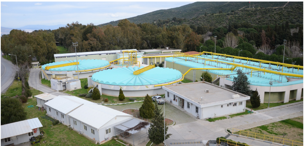
Güneybatı Atık Su Arıtma Tesisi
