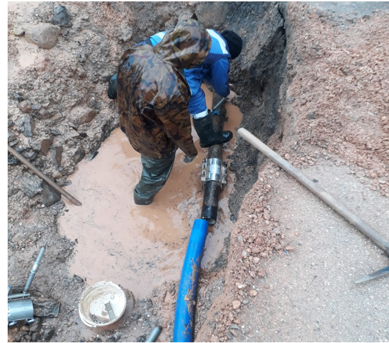
İZSU Ekipleri Su Kaçağı Tespit ve Müdahale Çalışması
