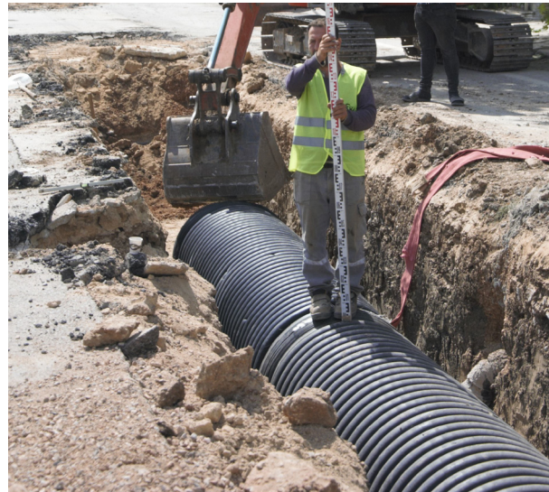
Urla İlçesi Muhtelif Mahalleleri Yağmur Suyu ve Atık Su Şebekesi İnşaatı İş'i
