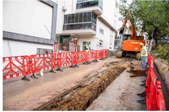
Karşıyaka İlçesi Yağmur Suyu Ayırıştırma Hattı İnşaatı İşi
