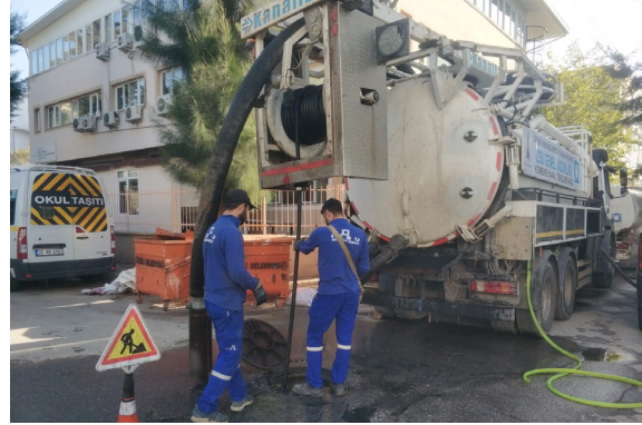
Kanalizasyon Hatlarının Temizliğinin Yapılması İşi
