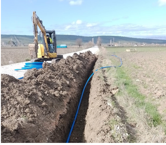
Kınık Balaban Mahallesi İçme Suyu Terfi Hattı İmalatı
