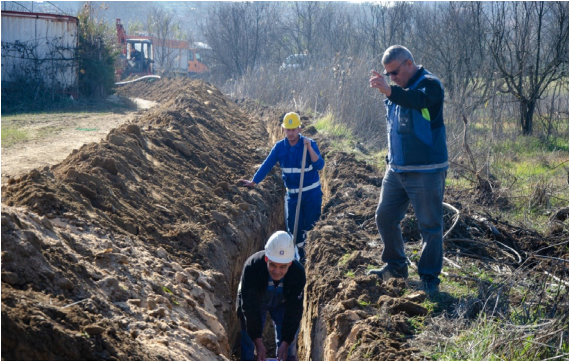
Ödemiş İlk Kurşun İçme Suyu Hattı Yapımı İşİ
