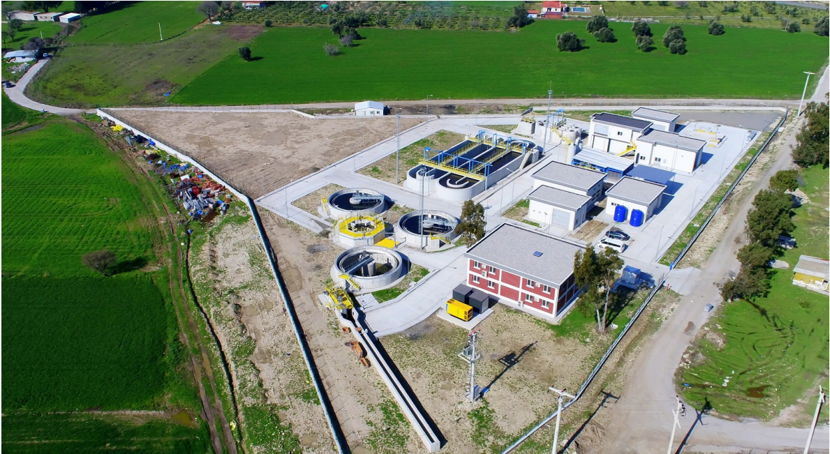
Foça Gerenköy Atık Su Arıtma Tesisi
