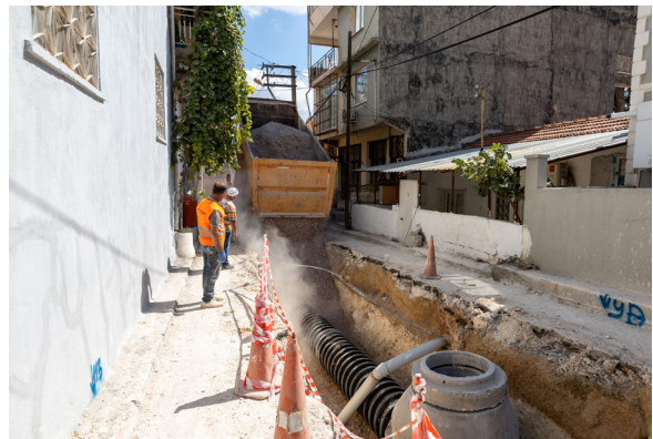
Karabağlar Yağmur Suyu Ayrıştırma Hattı İnşaatı İşi
