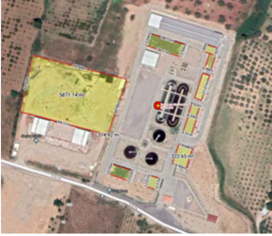
Kemalpaşa-Ulucak Atık Su Arıtma Tesisi Güneş Enerji Santrali Projesi
