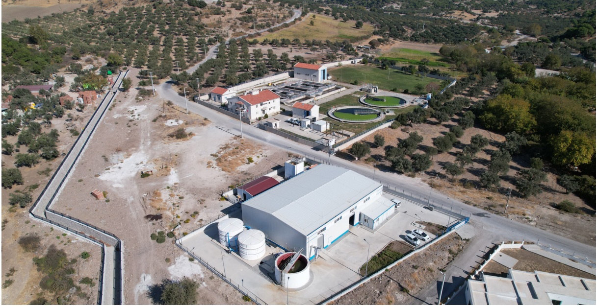
Dikili Çandarlı Göleti İçme Suyu Arıtma Tesisi Ve İletim Hattı Yapımı
