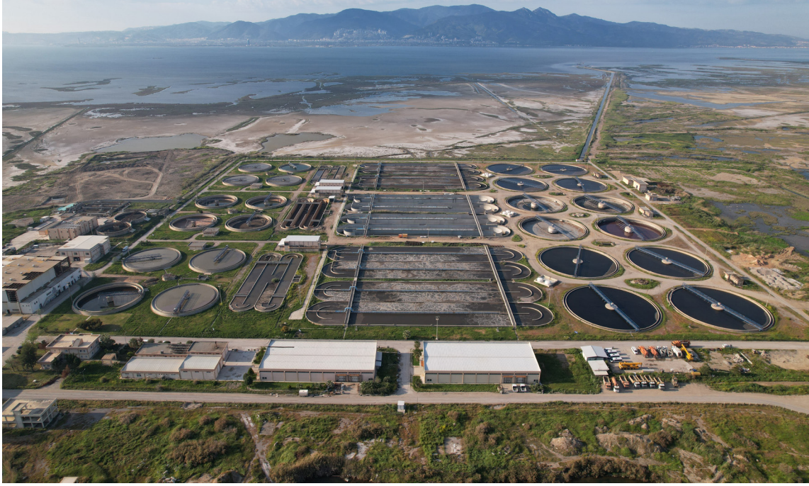
Çiğli Atık Su Arıtma Tesis Genel Revizyon Projesi
