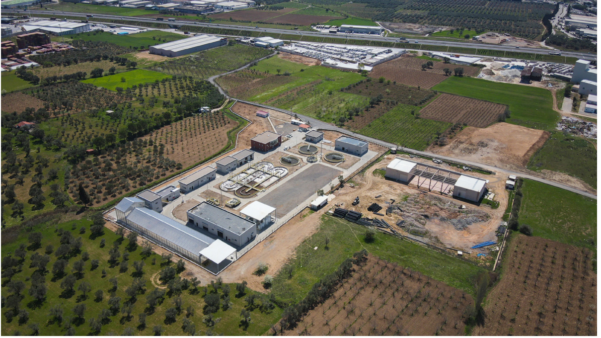
Kemalpaşa Ulucak Atık Su Arıtma Tesisi İnşaatı İşi
