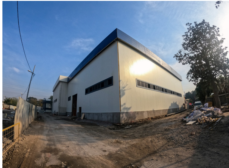
Halkapınar Kuyuları Arsenik Arıtma Tesisleri Kapasite Artırımı İnşaatı
