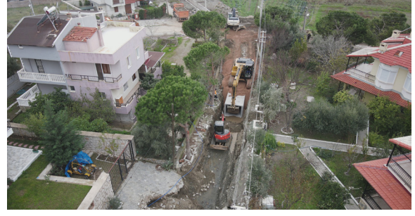
Seferihisar İlçesi Dere Bakım Onarım Çalışmaları
