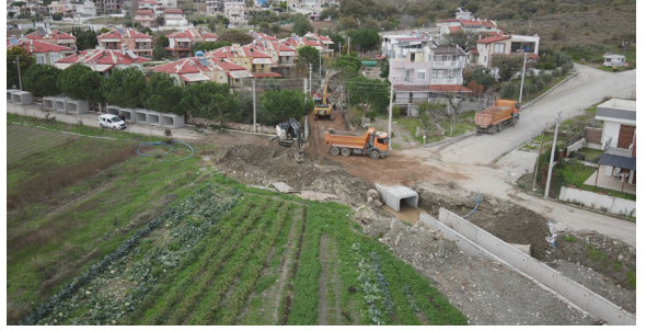
Seferihisar İlçesi Dere Bakım Onarım Çalışmaları
