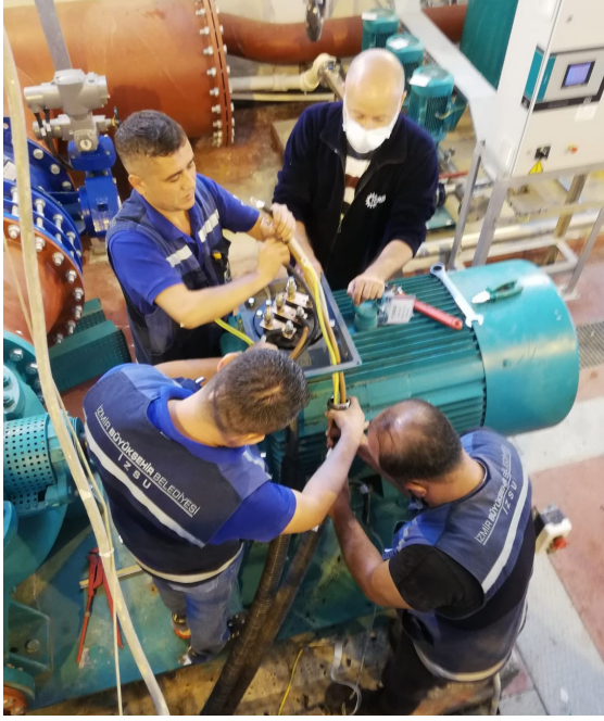
Kavaklıdere İçme Suyu Arıtma Tesisi Elektrik Bakım Çalışmaları
