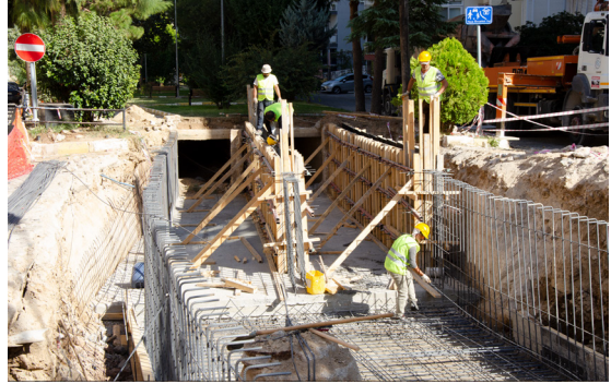
Hacı Ahmet Deresi Bakım Onarım Çalışmaları
