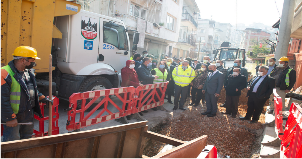
Konak İlçesi Gültepe Bölgesi Muhtelif Cadde ve Sokaklarında Yağmur Suyu Kanalı İnşaatı
