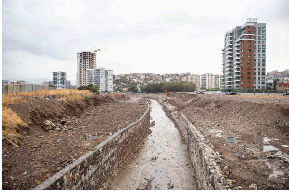
Karşıyaka İlçesi Bostanlı Deresi Yenileme Çalışmaları
