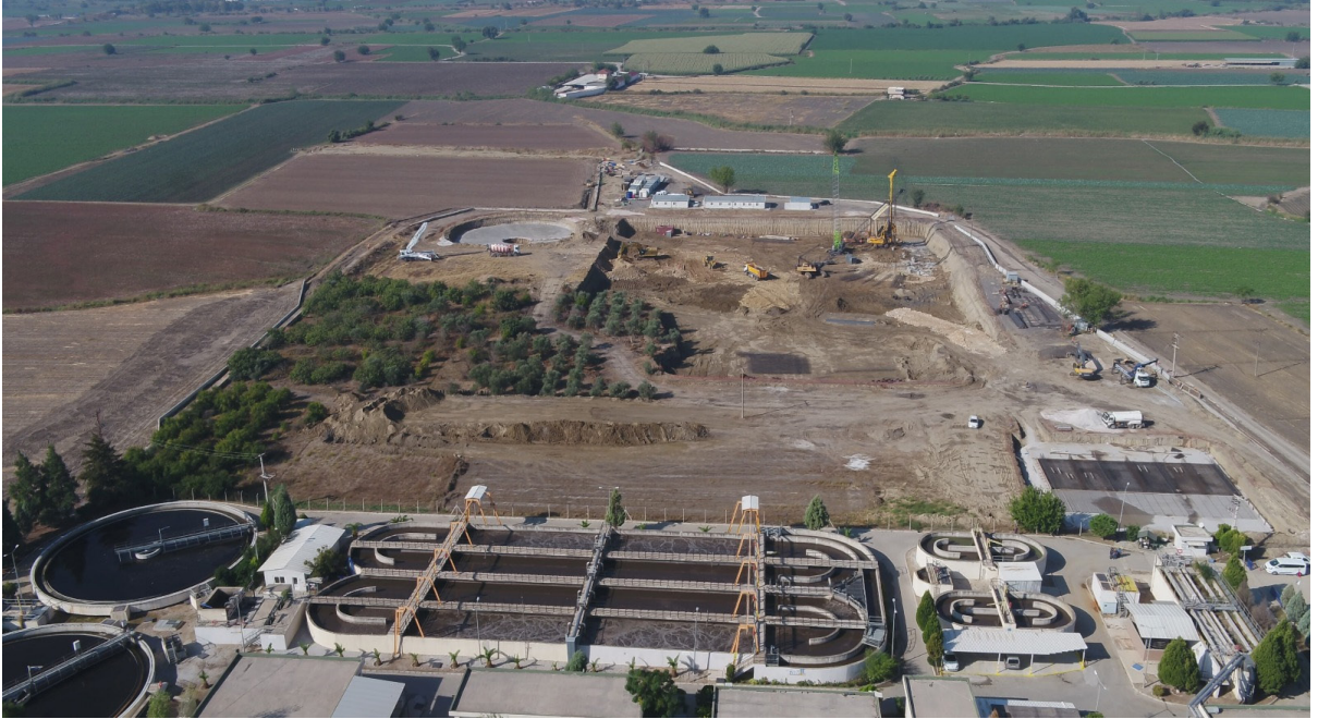
Torbalı 2. Etap Atık Su Arıtma Tesisi İnşaatı İşi
