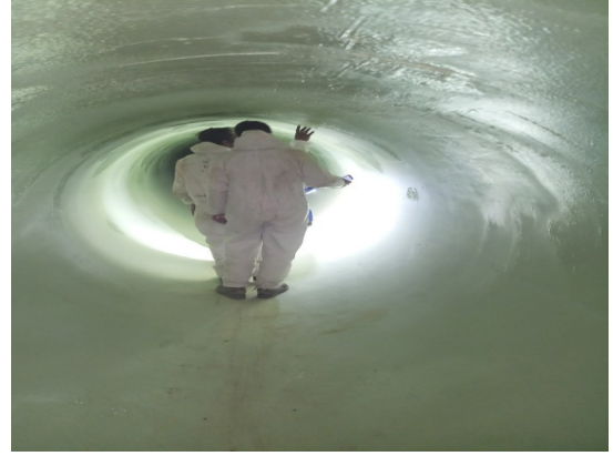
Göksu Pompa Çullu Depo Arası Ø1850 EB Boru İçi Onarım
