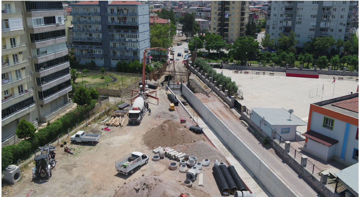
Buca İlçesi Merkez Muhtelif Mahalleleri Atık Su, Yağmur Suyu ve Kozagaç Deresi Islah İnşaatı İşİ
