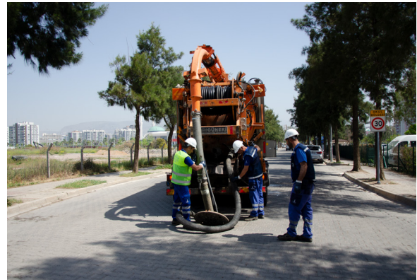
Kanalizasyon Hattı Temizliğinin Yapılması
