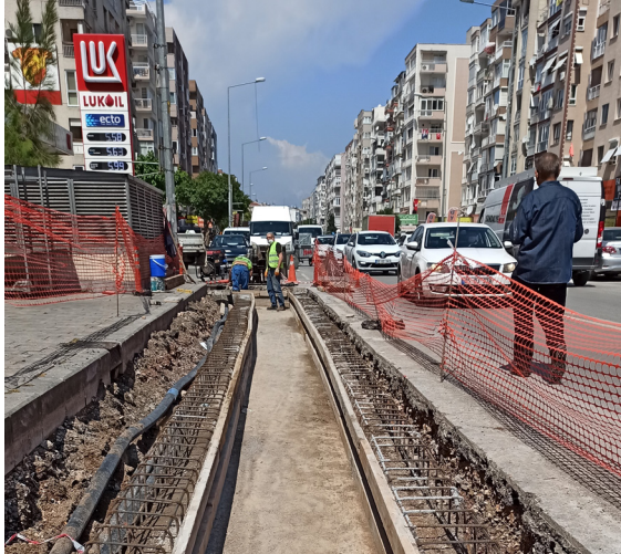
Kaynaklı Sıra Izgara ve U Kesitli Kapalı Yağmur Suyu Hatlarının Temizliği Faaliyeti
