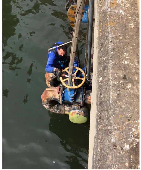
Vana Bakım Onarım Faaliyeti
