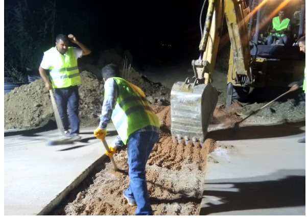
Foça İlçesi İçme Suyu İnşaatı İşi Gece Çalışması
