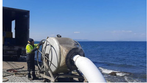
Kanalizasyon Hatlarının İç Kaplama Yöntemiyle İyileştirilmesi
