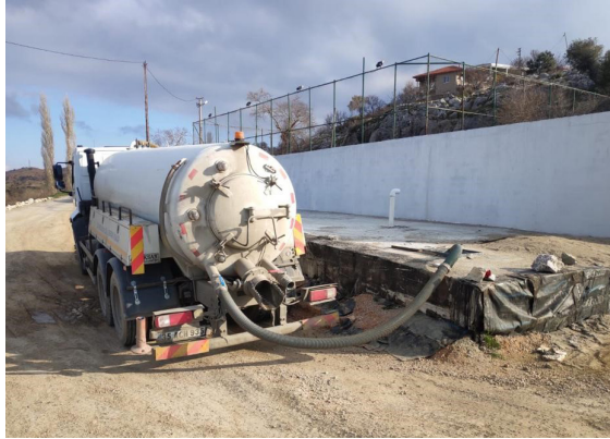
Güzelbahçe Betonarme Atık Su Toplama Havuzu Boşaltım Faaliyeti
