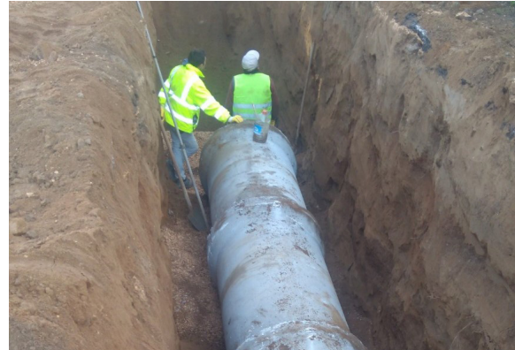
Ödemiş Merkez Atık Su Şebeke ve İletim Hattı İnşaatı İşi
