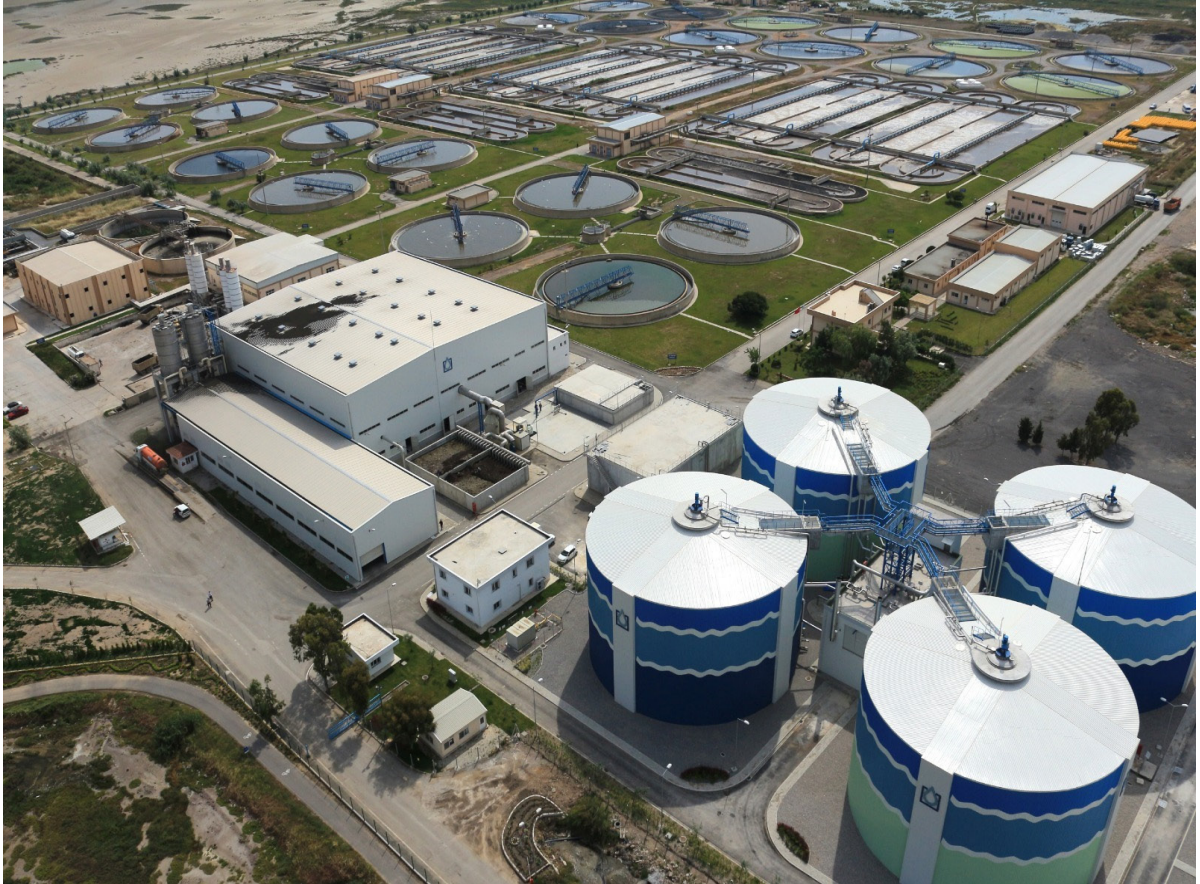
Çiğli Atık Su Arıtma Tesisi
