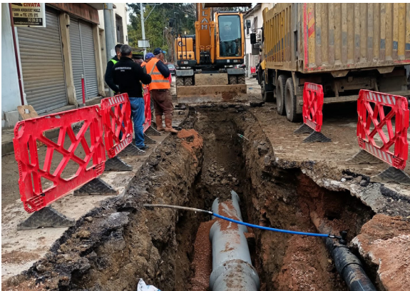
Kısa Metrajlı Kanalizasyon Hatlarının İmalatı
