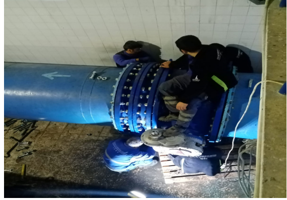
Cumhuriyet Depo Bakım Onarım Çalışmaları
