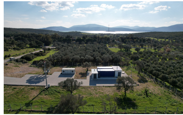
Urla Özbek Mahallesi Paket Atık Su Arıtma Tesisi İnşaatı İş
