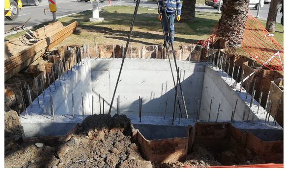
Karşıyaka İlçesi Zübeyde Hanım ve İnönü Mahalleleri Muhtelif Cadde ve Sokaklarda Yağmur Suyu Kanalı İnşaatı İşi
