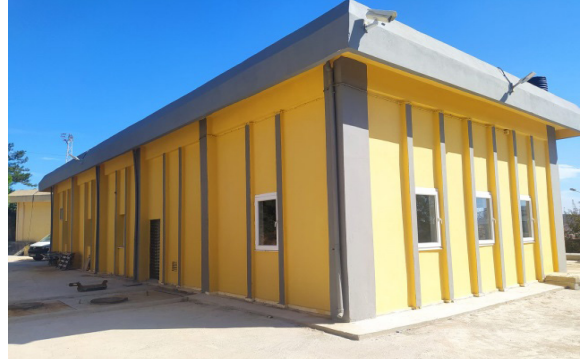
Çeşme İlçesi 18 No'lu Terfi Merkezi İnşaatı İş
