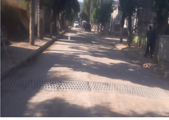
Kemalpaşa Ulucak, Kuyucak, Damlacık ve Ansızca Yağmur Suyu İnşaatı İşi
