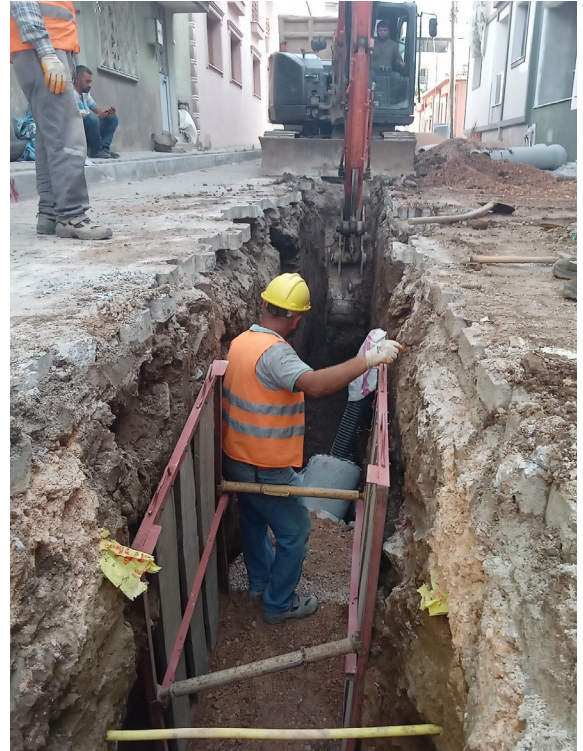
Kemalpaşa Bağyurdu, Yiğitler, Ören, Armutlu, Yukarıkızılca, Aşağıkızılca, Örnekköy ve Çiniliköy Yerleşimleri Altyapı İnşaatı İşi
