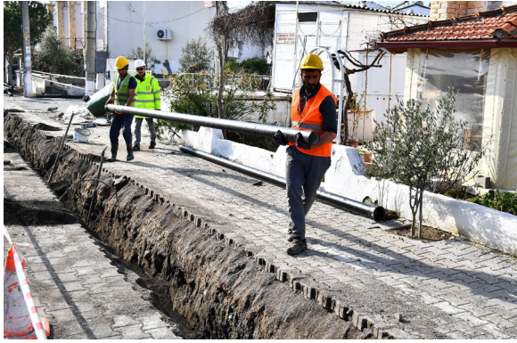
Dikili İlçesi Merkez İçme Suyu İnşaatı İşi
