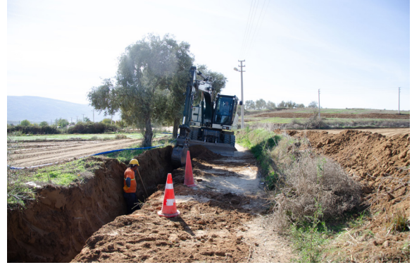
Tire İlçesi Derebaşı (Bayraktepe) Mahallesi İçme Suyu İnşaatı İşİ
