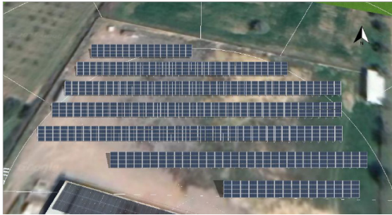
Kemalpaşa-Ulucak Atık Su Arıtma Tesisi Güneş Enerji Santrali Projesi
