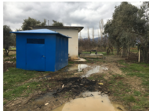
Kiraz Şemsiler Sondaj Kuyusu İnşaatı
