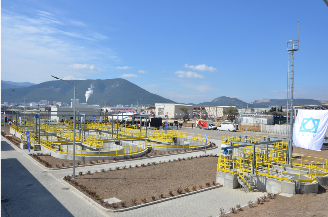
Kemalpaşa Ulucak Atık Su Arıtma Tesisi
