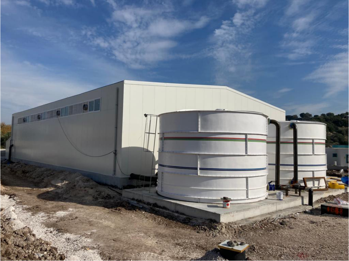
Dikili Çandarlı Göleti İçme Suyu Arıtma Tesisi ve İletim Hattı Yapım İnşaatı
