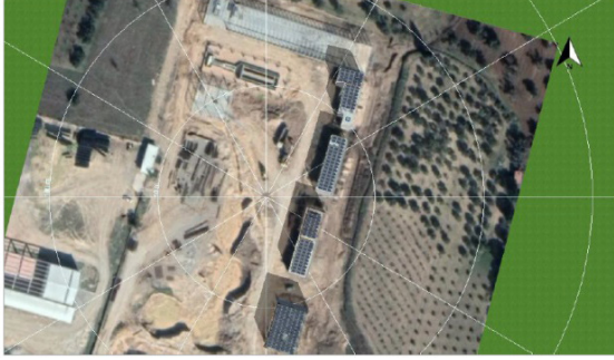
Kemalpaşa-Ulucak Atık Su Arıtma Tesisi Güneş Enerji Santrali Projesi
