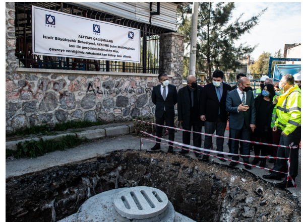
Buca Merkez Muhtelif Mahalleleri Atık Su, Yağmur Suyu ve Kozagaç Deresi Islah İnşaatı İşi
