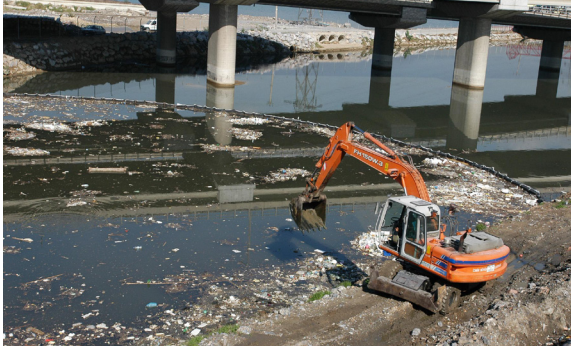
Yüzer Bariyer Temizlik Çalışmaları
