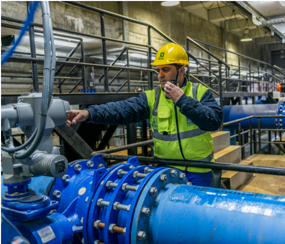
Sarıköz İçme Suyu Arıtma Tesisleri Filtre Binası
