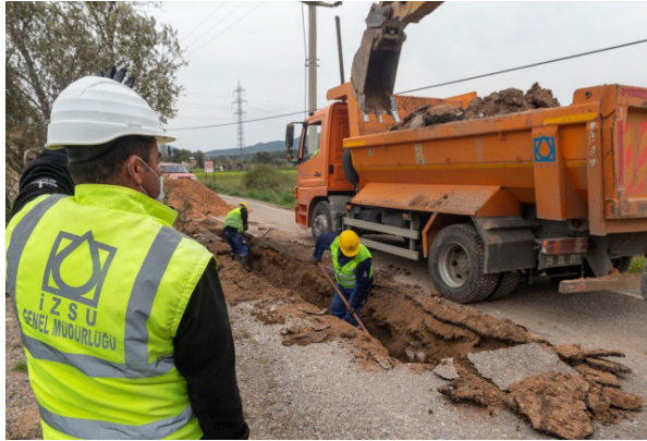
Urla İlçesi İçmeler ile Çeşme Arası 2.Etap İçme Suyu İletim Hattı ile Karaburun İlçesi Bozköy Gölü İçme Suyu İletim Hattı İnşaatı İşi
