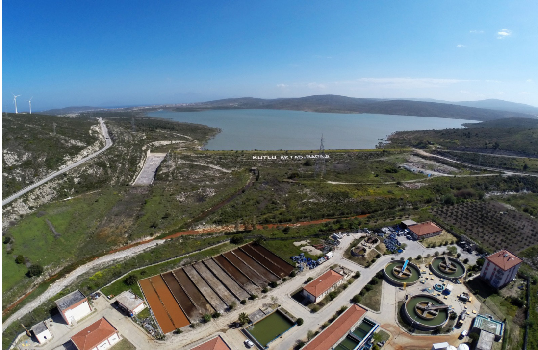
Kutlu Aktaş Barajı
