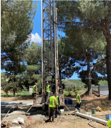
Bergama İlçesi Sondaj Kuyusu İnşaatı
