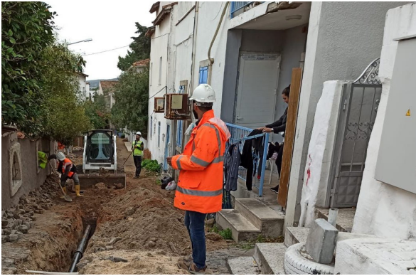
Çeşme İlçesi İçme Suyu Şebeke İnşaatı İşİ
