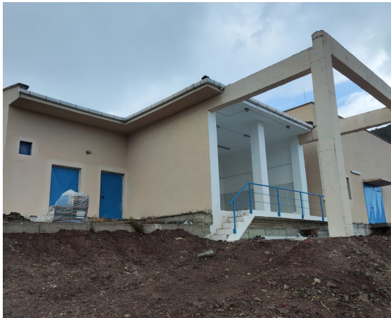
Foça İlçesi İçme Suyu İnşaatı 5.000 m 3 'lük Depo Yapımı
