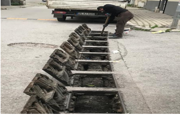
Tekli Yağmur Suyu Izgaralarının Bağlantı Kollarının Temizliğinin Yapılması Faaliyeti
