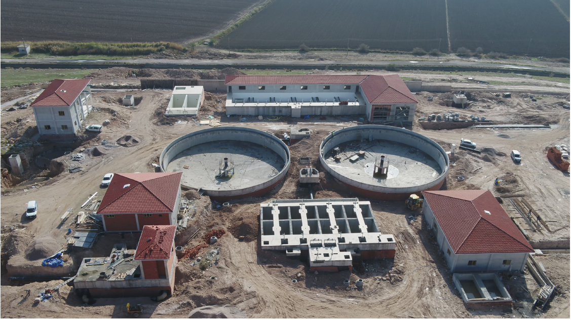
Foça, Yenifoça, Musabey Kuyuları İçme Suyu Arıtma Tesisi İnşaatı
