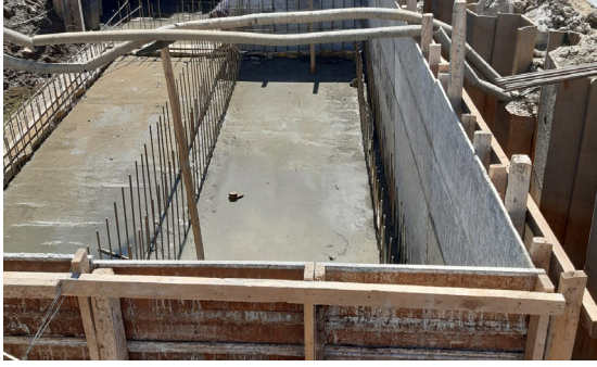
Konak İlçesi Üçkuyular Askeriye İçi Betonarme Havuz İnşaatı işi
