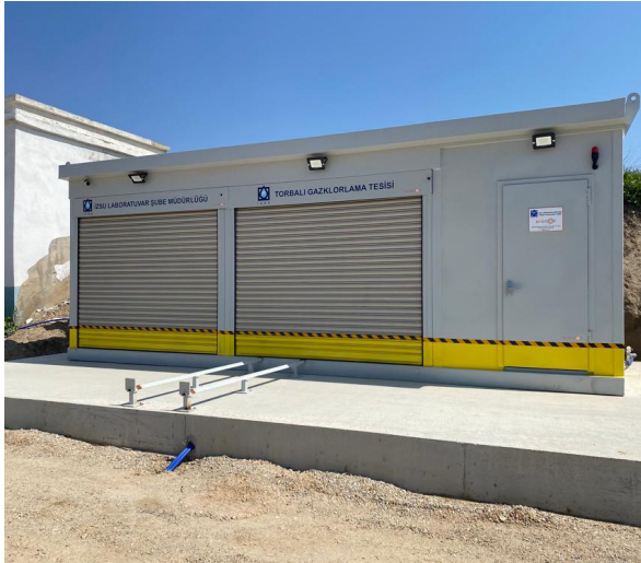
Torbalı Gaz Klorlama Tesisi
