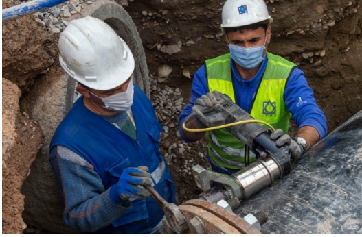
İçme Suyu Hattı Yenileme Faaliyeti
