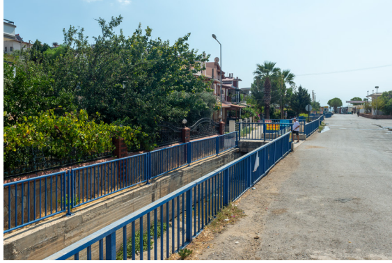
Seferihisar İlçesi Dere Kenarına Korkuluk Yapımı
