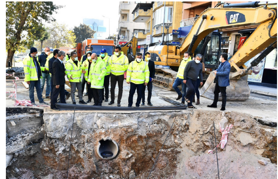
Gazimür Emrez Deresi Bakım Onarım Çalışmaları
