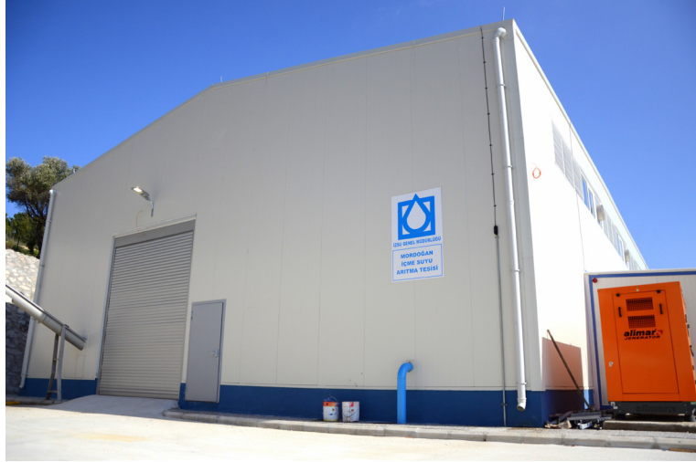
Karaburun Mordoğan Göleti İçme Suyu Arıtma Tesisleri
