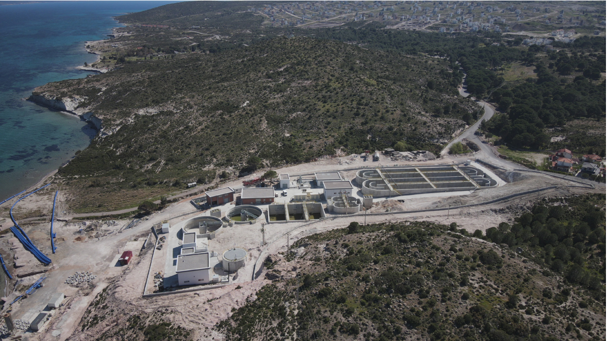
Mordoğan Atık Su Arıtma Tesisi İnşaatı İş
