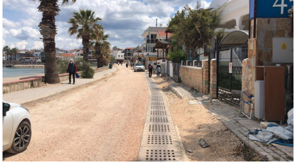
Mordoğan Mahallesi Yağmur Suyu Hattı İnşaatı İş
