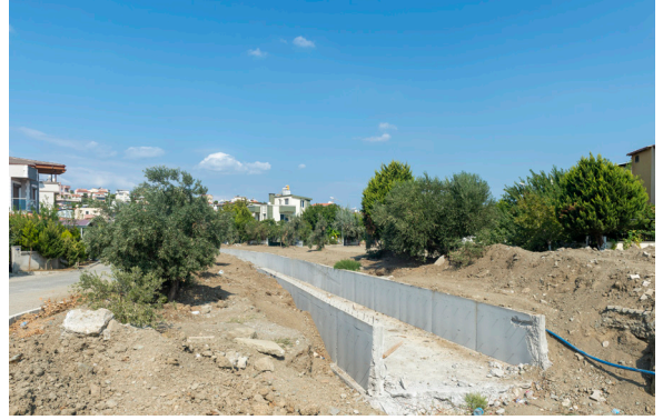
Seferihisar İlçesi Dere Bakım Onarım Çalışmaları
