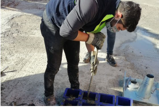
Teste Gönderilmek Üzere Betondan Numune Alınması
