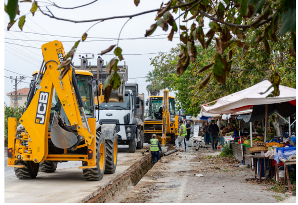
Seferihisar İçme Suyu Şebeke İnşaatı İşİ
