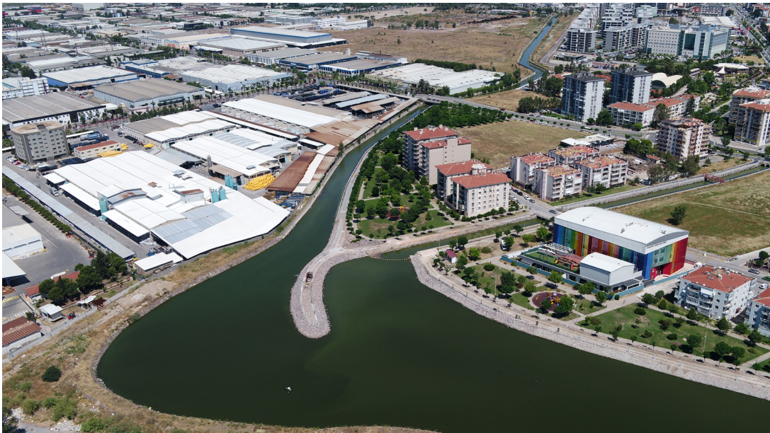
Çiğli AOSB Deresi Islah Çalışmaları Sonrası Görünüm
