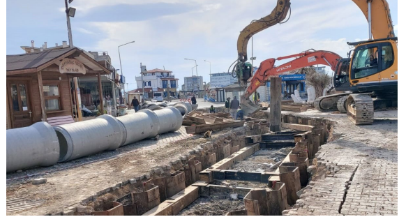
Mordoğan Mahallesi Atık Su Şebeke İnşaatı İş
