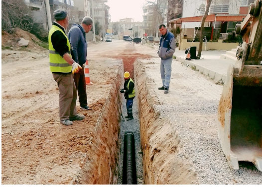
Kemalpaşa İlçesi Ulucak, Kuyucak, Damlaçık ve Ansızca Yerleşimleri Altyapı İnşaatı İşi
