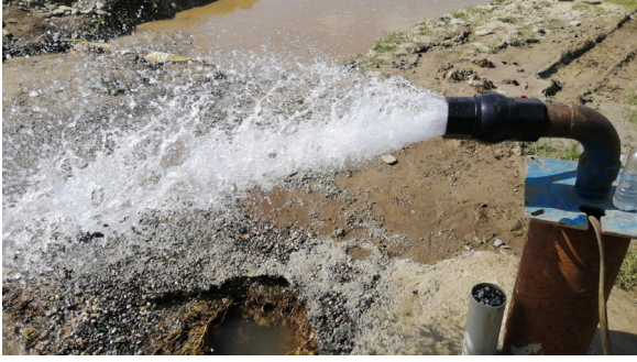
Kınık Yaylaköy-2 Sondaj Kuyusu İnşaatı
